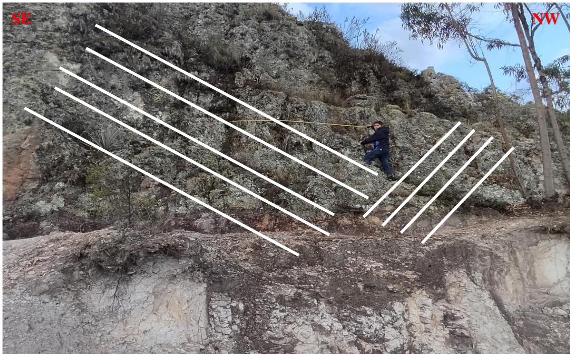
Foto 9: Afloramiento del macizo rocoso de areniscas, con las coordenadas E: 789814.11, N: 9204339.84
