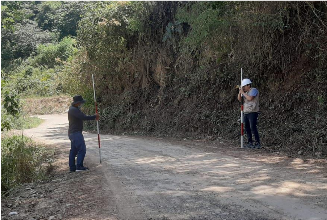
Fotografía 13. Medición del peralte en la calzada de la carrera.
