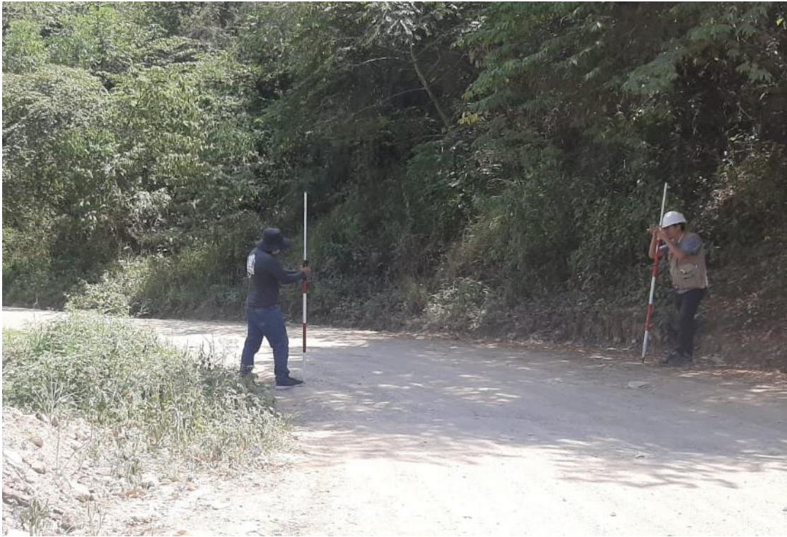
Fotografía 11. Medición del peralte en la calzada de la carrera.
