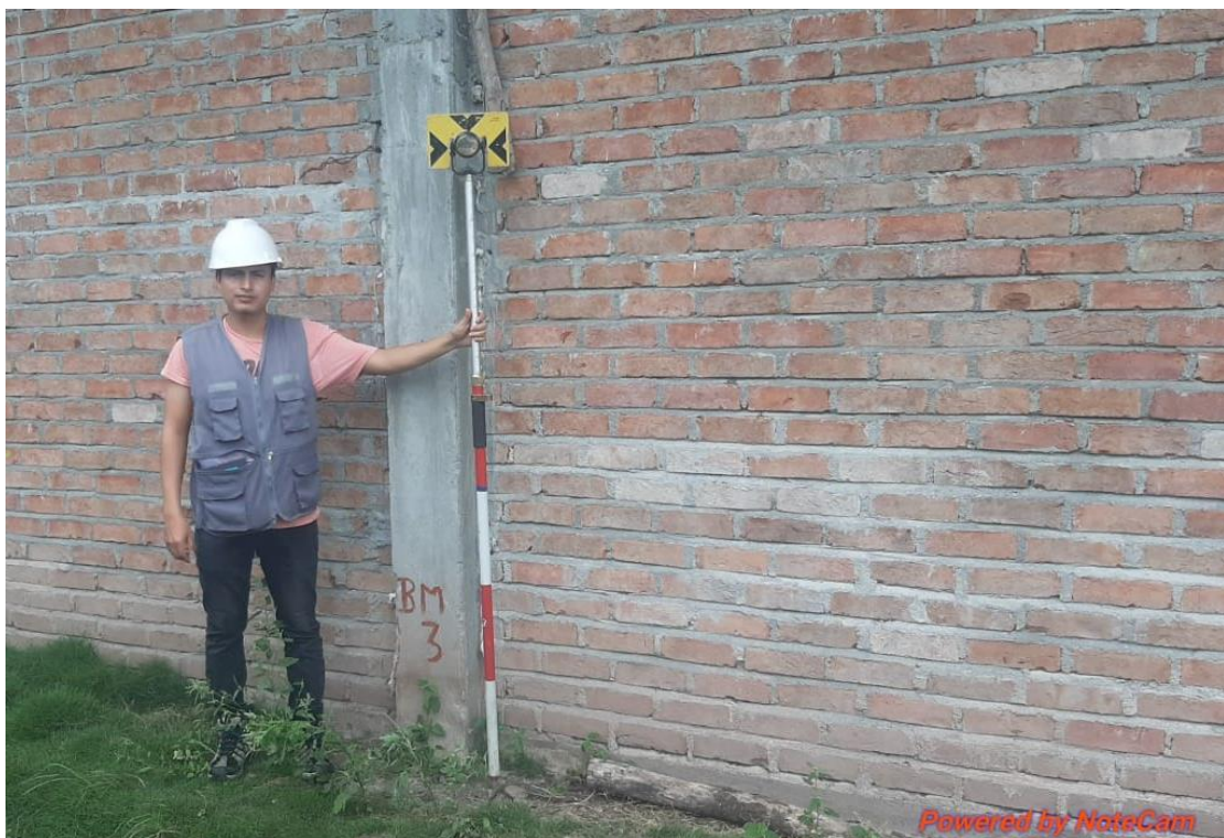
Fotografía 6. Marcación de BM3 de carretera.
