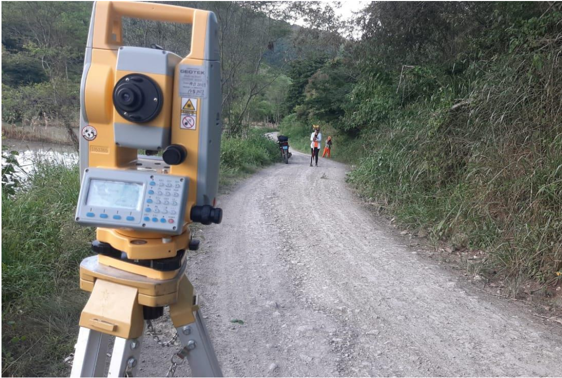
Fotografía 3. Toma de datos en el eje y esquina de calzada.
