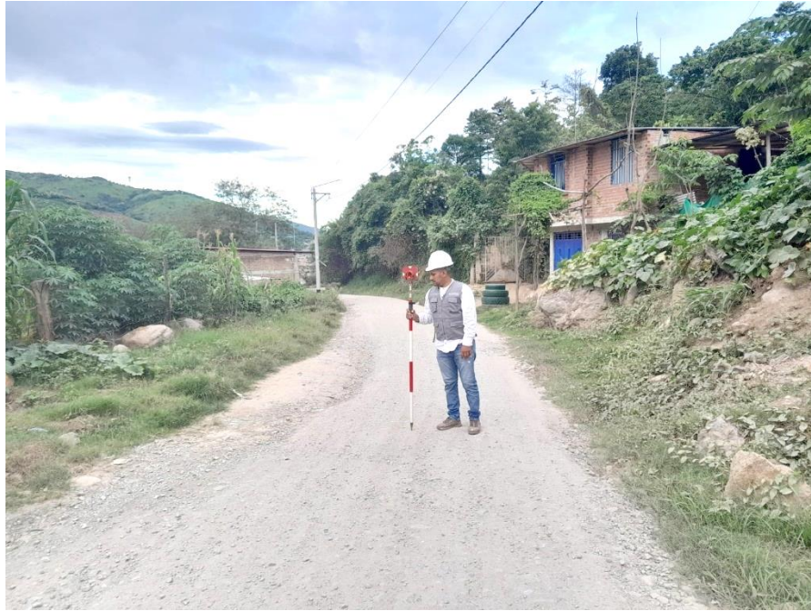
Figura 28.- Levantamiento topográfico del tramo
