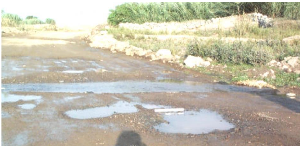
Figura 9.- Gravedad 3: Necesita una reconstrucción
