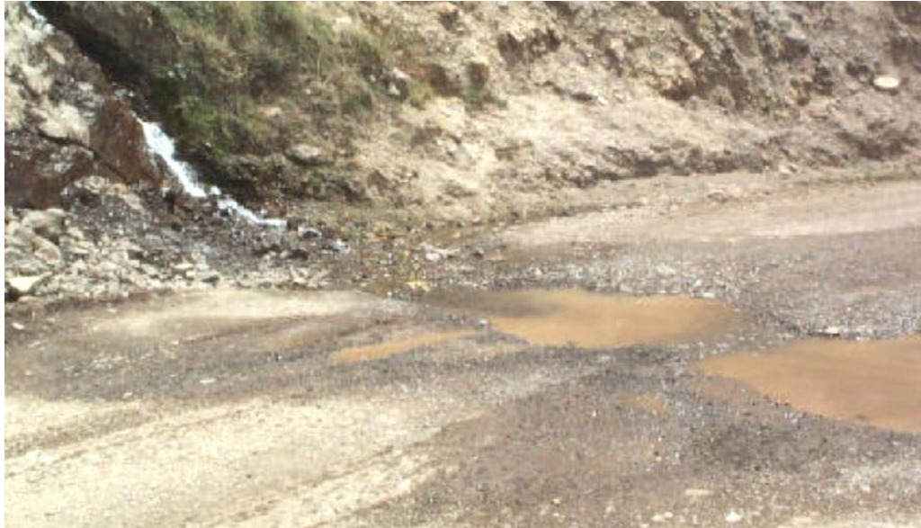
Figura 12.- Cruce de agua
