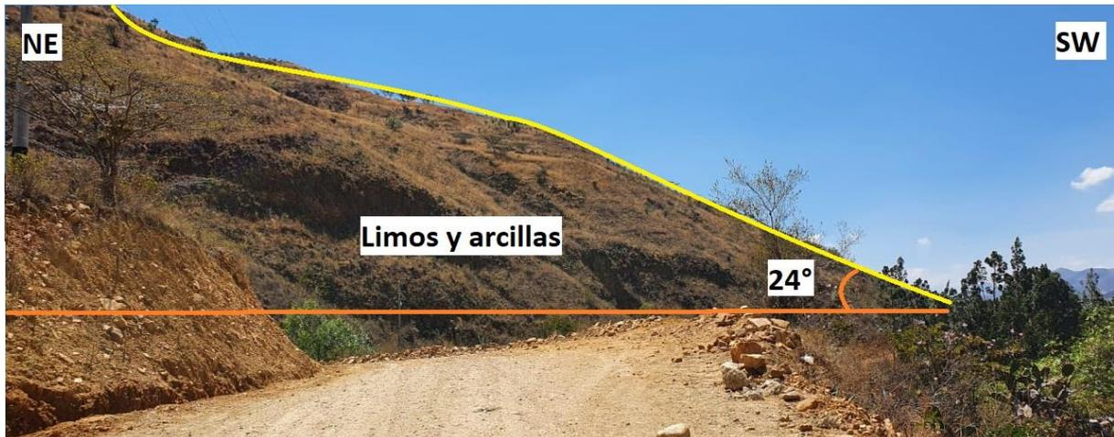
Foto 14: Estación 8, N: 9194642 E: 788638 C: 3160 m.s.n.m., Talud de depósitos cuaternarios conformados por limos y arcillas.
