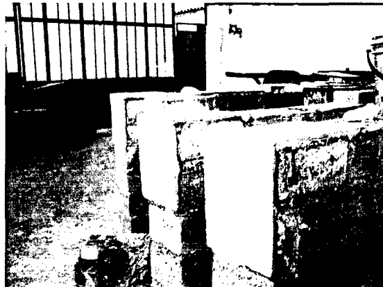
Foto 28. Capping Terminado en todos los Muretes de todas las Combinaciones.
