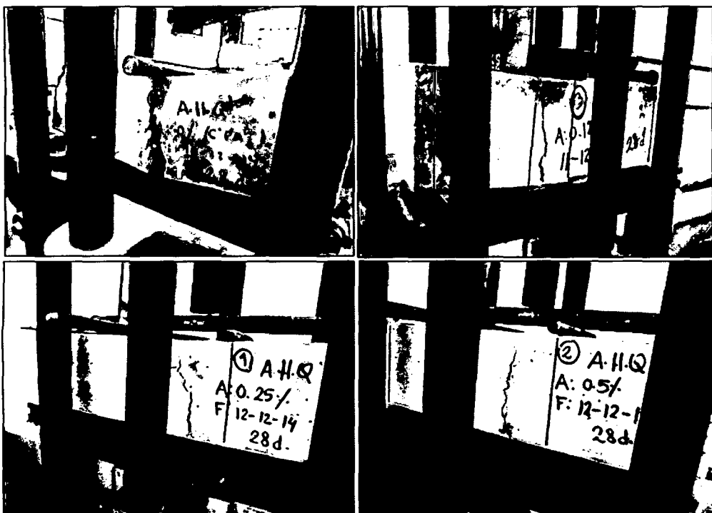
Foto N° 23: Fisuración de los especímenes prismáticos ensayados a flexión.
