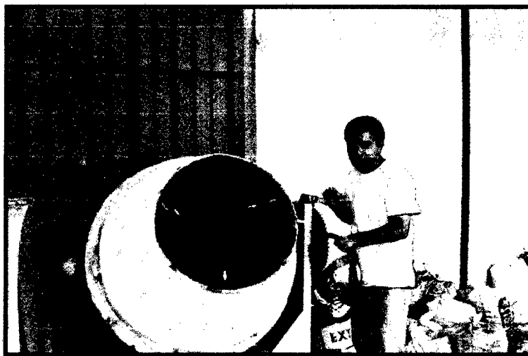
Fotografía N° 4: Se puede observar la tanda de la mezcla de prueba.
