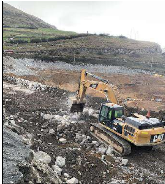
Figura 11: Excavadora esperando para cargar
