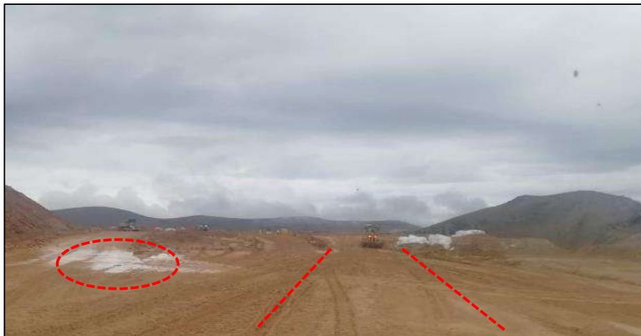
Figura 32: Limpieza del lodo con motoniveladora en zona de descarga
