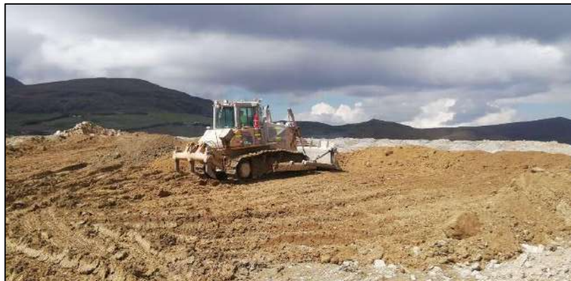
Figura 30: Empuje de material y nivelación de piso con tractor oruga.
