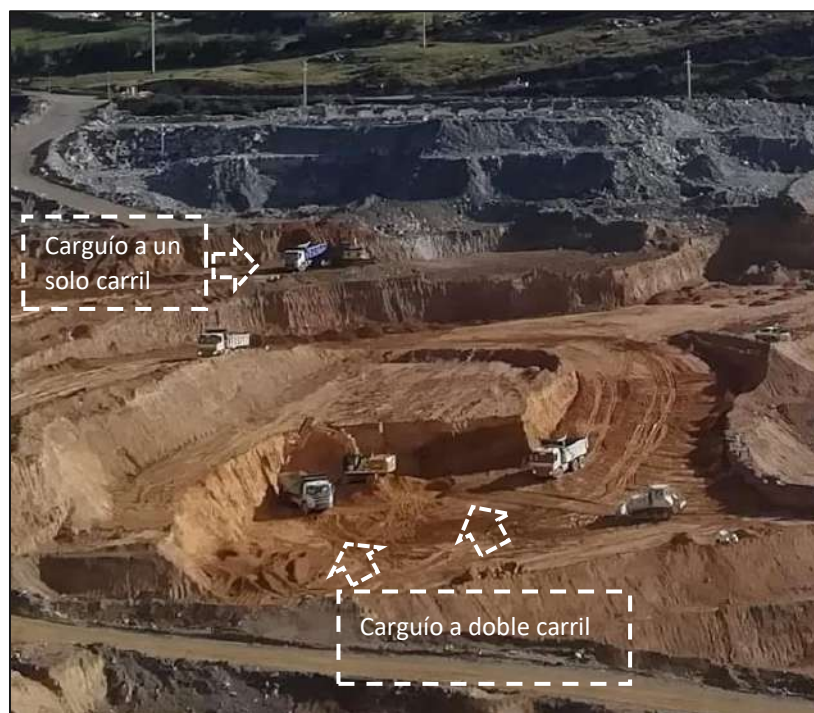
Figura 14: Carguío a un carril y a doble carril en el nivel 3350 y 3360 en la zona de carguío de óxidos.
