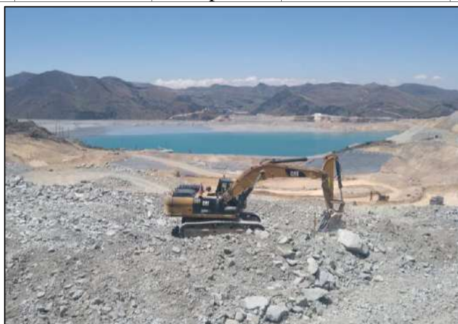
Figura 15: Excavadora 336 DL, habilitando la rampa en la zona de rocas (inadecuados) en el nivel 3800
