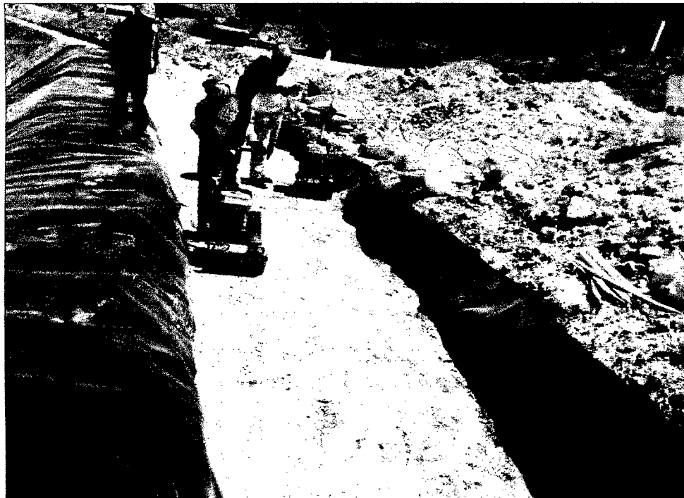
Foto N° 10: Detalle del anclaje de la Geomembrana
