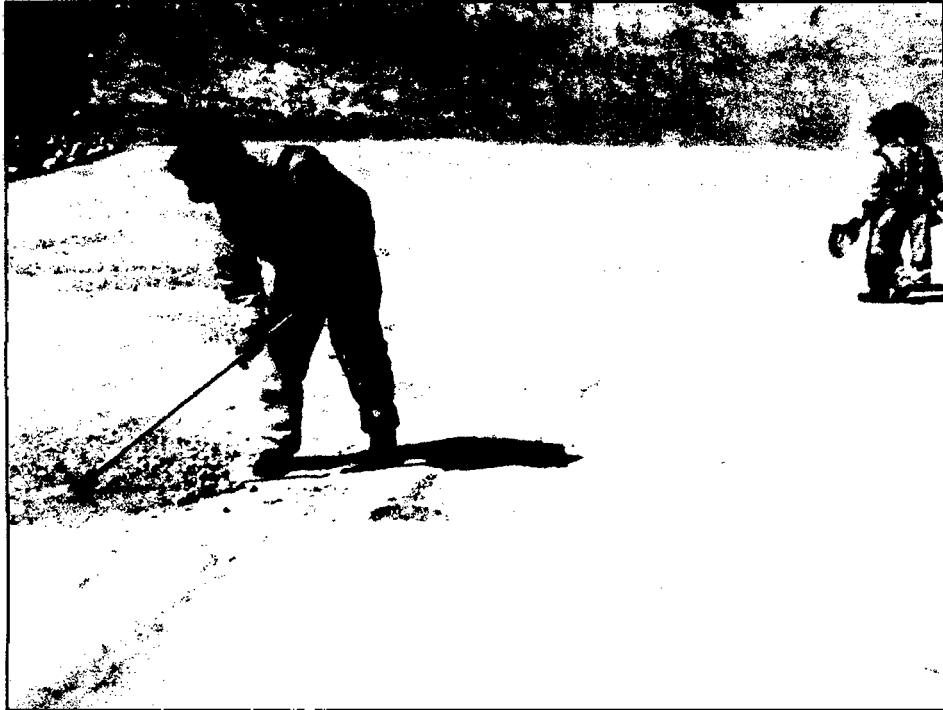
Foto N° 11: Retiro de material punzante y partículas que excedan el tamaño máximo nominal en la base.
