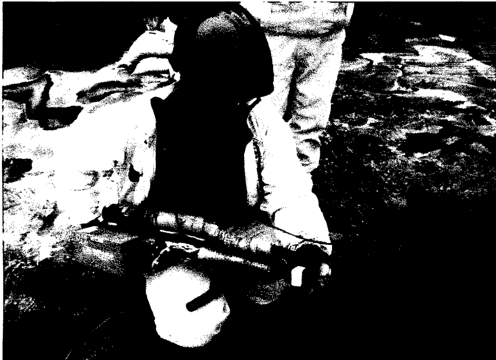
Foto N° 21: Realización de ensayos in situ de la soldadura por extrusión.
