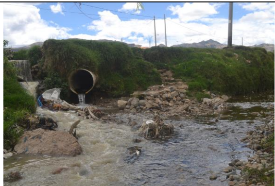
Figura 46 Vertido de aguas negras al río San Lucas en la EM2
