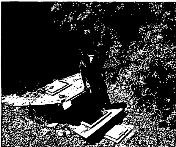
Foto 3: Captación de ladera Pomacocha.
