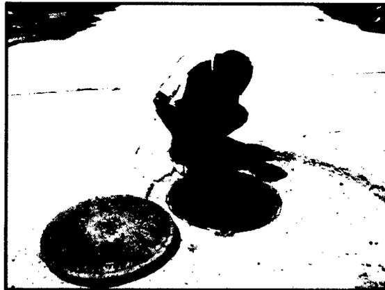
**Figura 2 – 3** Medición con wincha de profundidad de buzones
