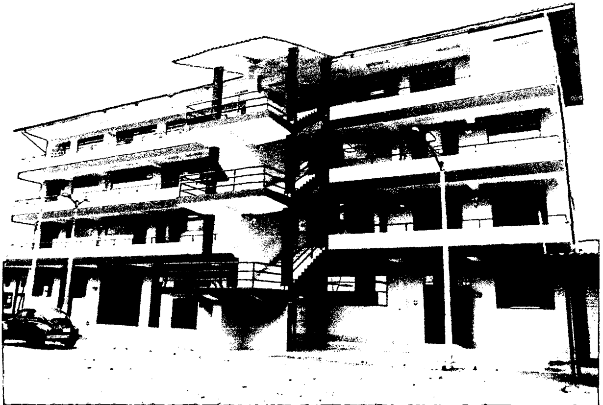
Fotografía 1. 3. Fachada de Senati Cajamarca.
