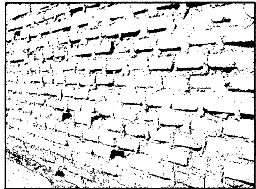
Figura 23. Pabellón 1. Mampostería de ladrillo de mala calidad susceptible al agrietamiento.
