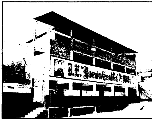
Figura 26. Pabellón 1. Edificio cimentado sobre terreno con pendiente menor al 10%.
