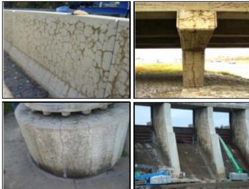
Figura 02. Perfil de un puente que muestra daños causados por reacción álcali-sílice Lima-Perú
