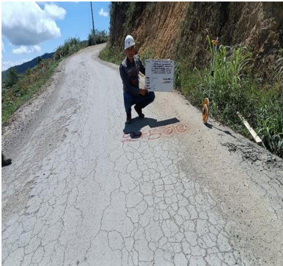
Fotografía N° 13 Se identifica la progresiva 2+500 del tramo Pimpingos – Cruce el Palturco
