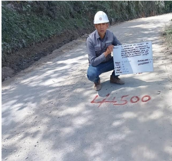
Fotografía N° 29. Se identifica la progresiva 4+500 del tramo Pimpingos – Cruce el Palturco
