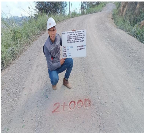
Fotografía N° 9. Se identifica la progresiva 2+000 del tramo Pimpingos – Cruce el Palturco
