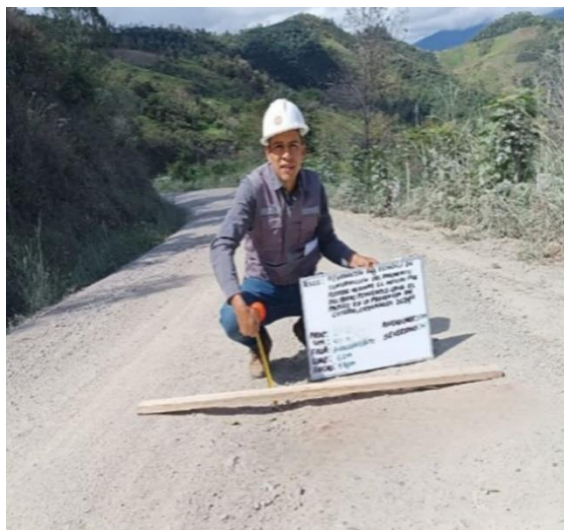
Fotografía N°6. Se evidencia ahuellamiento (falla 15).
