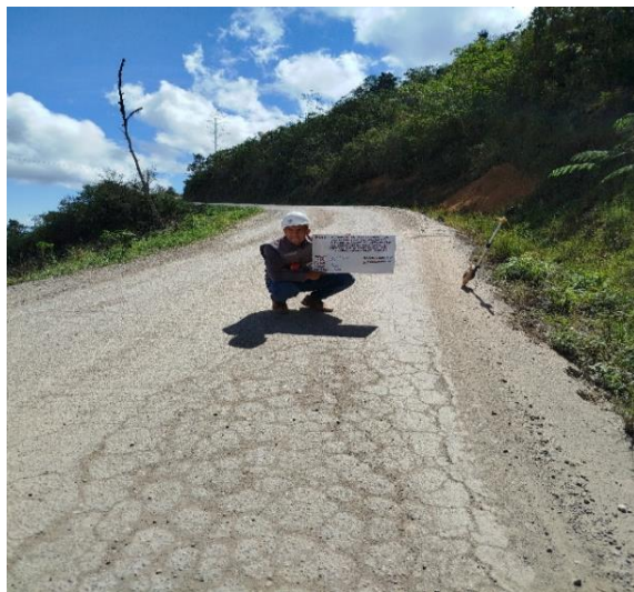
Fotografía N° 35. Se evidencia piel de cocodrilo ( falla 1).
