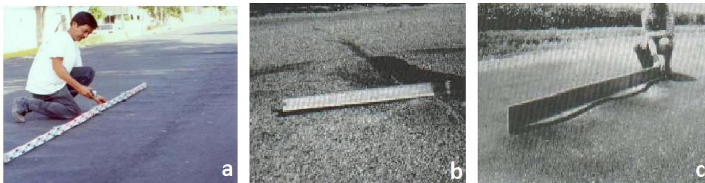
**Figura 2.13. Corrugaciones de nivel de severidad bajo (a), medio (b) y alto (c).**
