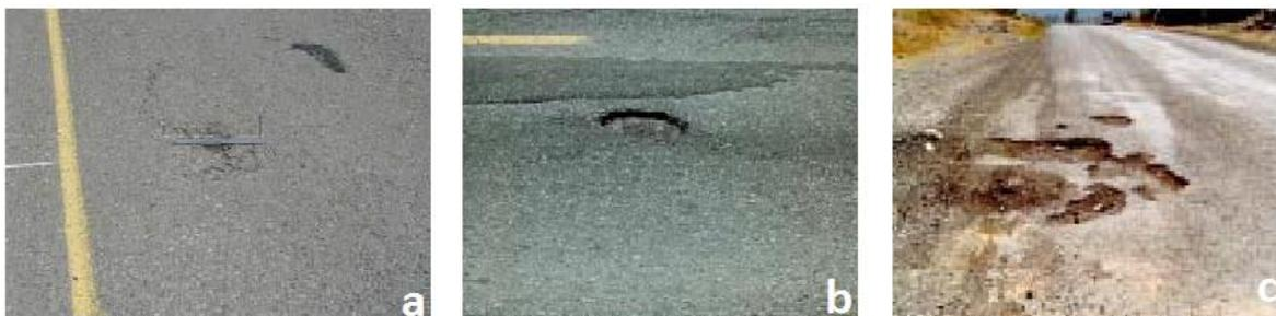
Figura 2.28. Baches de severidad bajo (a), medio (b) y alto (c).
