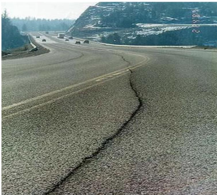
Figura 2.22. Falla Tipo: Fisuras Longitudinales y Transversales
