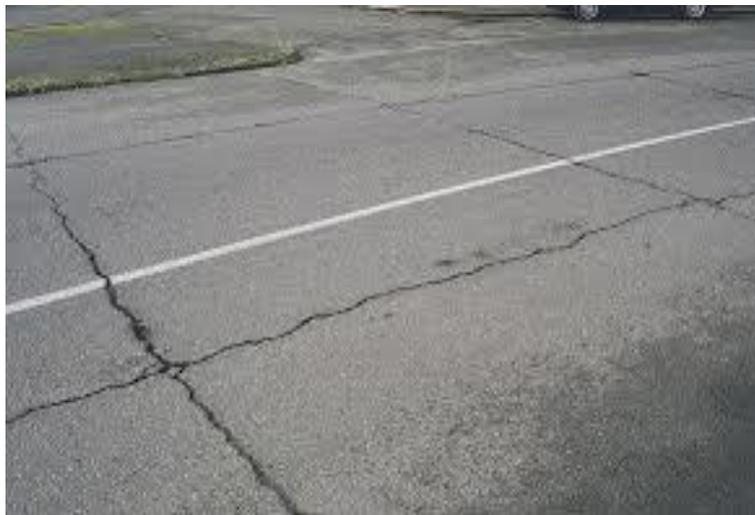
**Figura 2.18. Falla Tipo: Fisuras de Reflexión de Junta**
