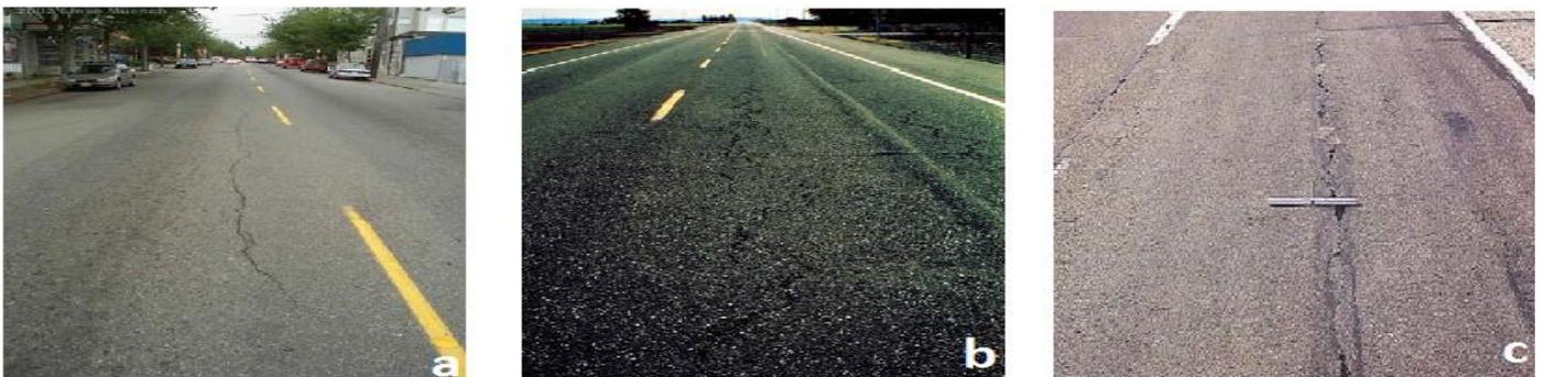
Figura 2.23. Fisuras Longitudinales y Transversales de severidad bajo (a), medio (b) y alto (c).
