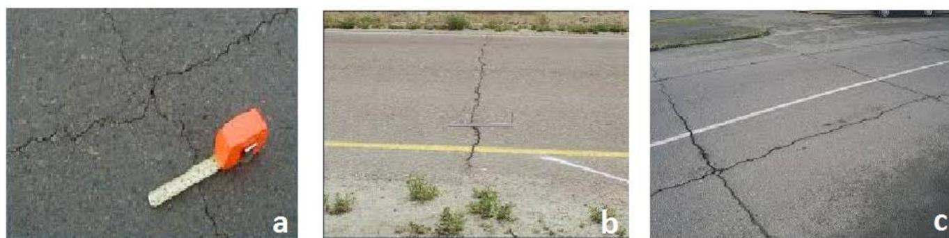
**Figura 2.19.** Fisuras de Reflexión de Junta de severidad bajo (a), medio (b) y alto (c).
