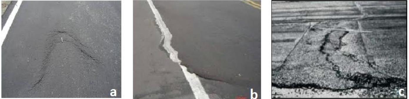
Figura 2.36. Hinchamiento de severidad bajo (a), medio (b) y alto (c).
