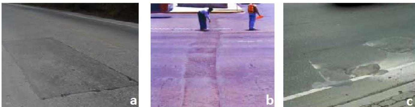
**Figura 2.25. Falla Tipo: Parches y Parches de cortes utilitarios de severidad bajo (a), medio (b) y alto (c).**
