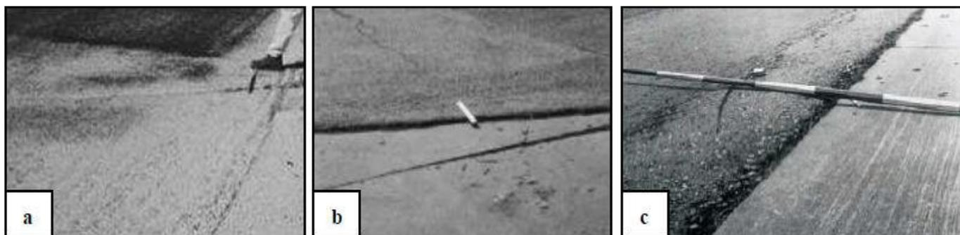
Figura 2.32. Desplazamiento de severidad bajo (a), medio (b) y alto (c). Fuente: Rodríguez, 2009)
