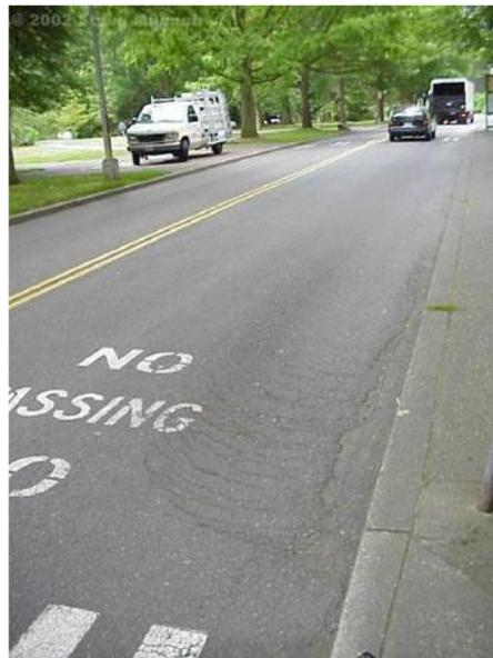
**Figura 2.31. Falla Tipo: Desplazamientos**
