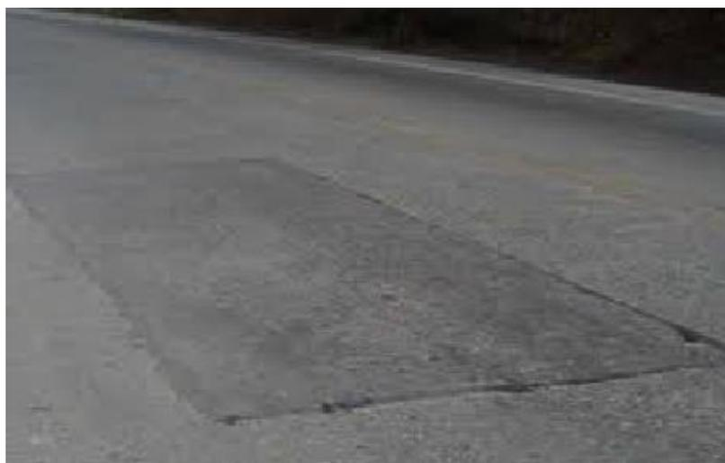
**Figura 2.24. Falla Tipo: Parches y Parches de cortes utilitarios**
