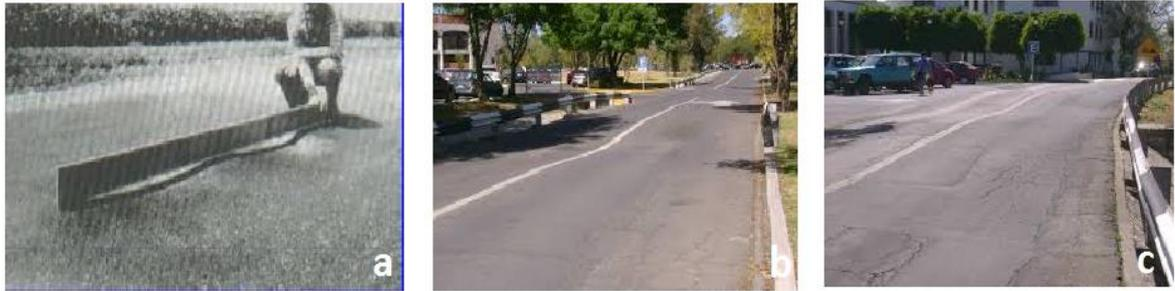
Figura 2.15. Depresiones de nivel de severidad bajo (a), medio (b) y alto (c).
