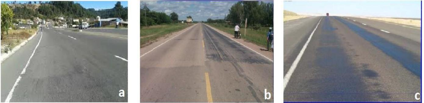
Figura 2.07. Exudación de nivel de severidad bajo (a), medio (b) y alto (c).
