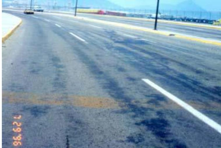
**Figura 2.06. Falla Tipo: Exudación**
