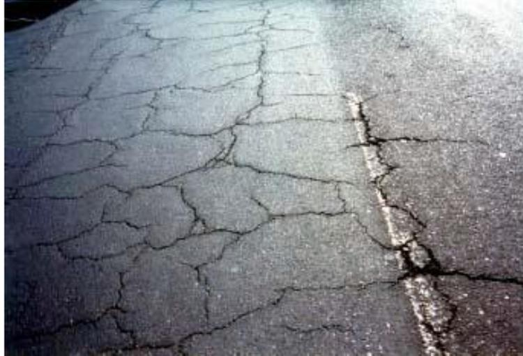
**Figura 2.08. Falla Tipo: Fisuras en Bloque**
