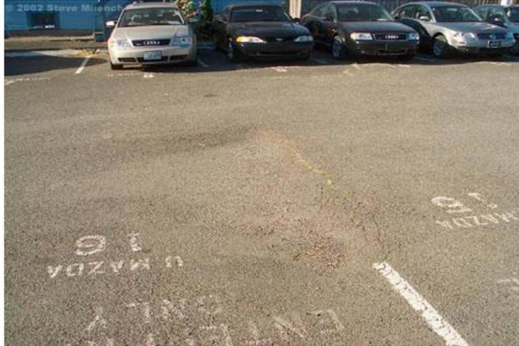
**Figura 2.10. Falla Tipo: Abultamiento y Hundimiento.**
