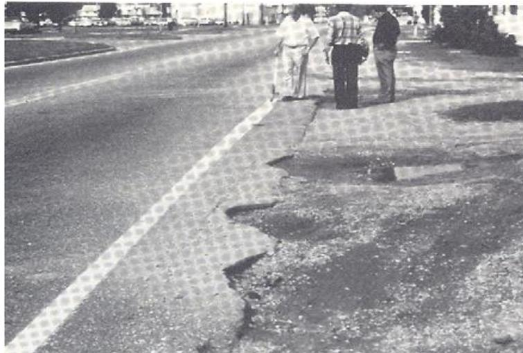
Figura 2.16. Falla Tipo: Fisuras de Borde
