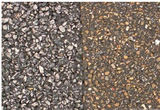
**Figura 2.26. Falla Tipo: Agregado Pulido**
