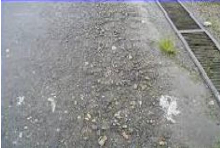
**Figura 2.37. Falla Tipo: Peladura por intemperismo y desprendimiento de agregados**
