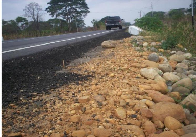
**Figura 2.20. Falla Tipo: Desnivel Carril - Berma**
