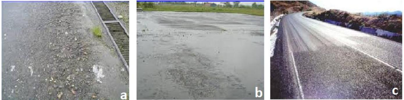
**Figura 2.38. Peladura por Intemperismo y desprendimiento de agregados de severidad bajo (a), medio (b) y alto (c).**
