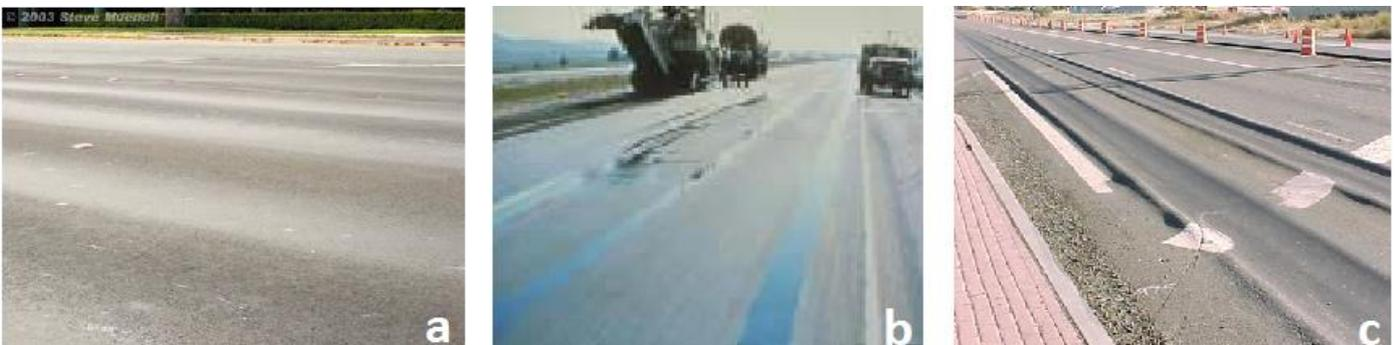
**Figura 2.30. Ahuellamiento de severidad bajo (a), medio (b) y alto (c).**
