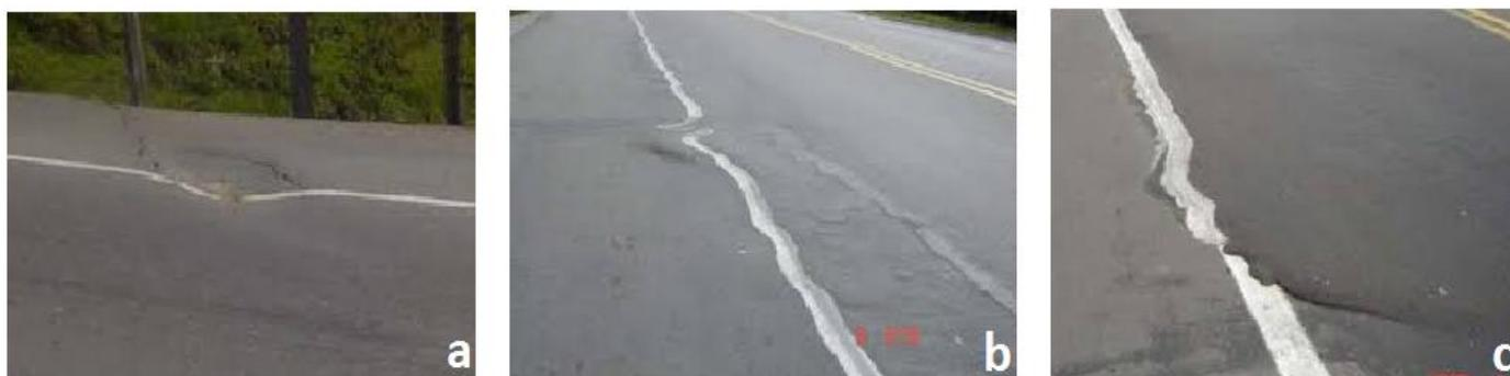
**Figura 2.11. Abultamientos y Hundimientos de nivel de severidad bajo (a), medio (b) y alto (c).**
