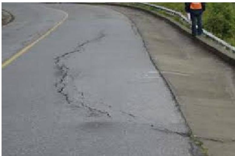
**Figura 2.33. Falla Tipo: Fisura Parabólica o por Deslizamiento**
