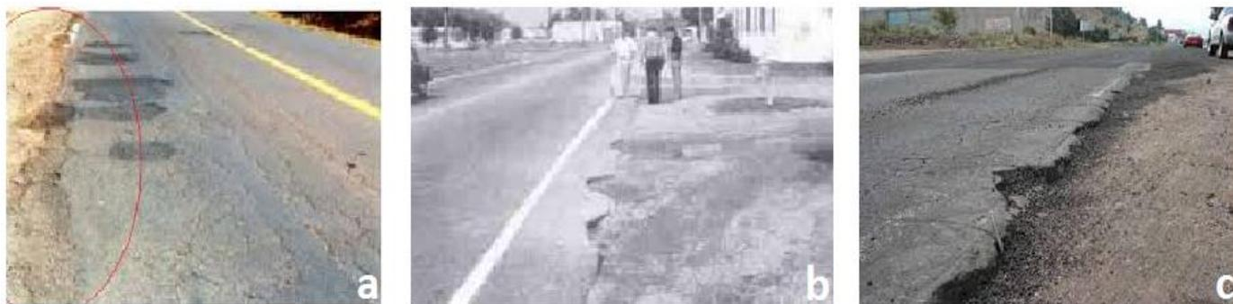
Figura 2.17. Fisuras de Borde de severidad bajo (a), medio (b) y alto (c).
