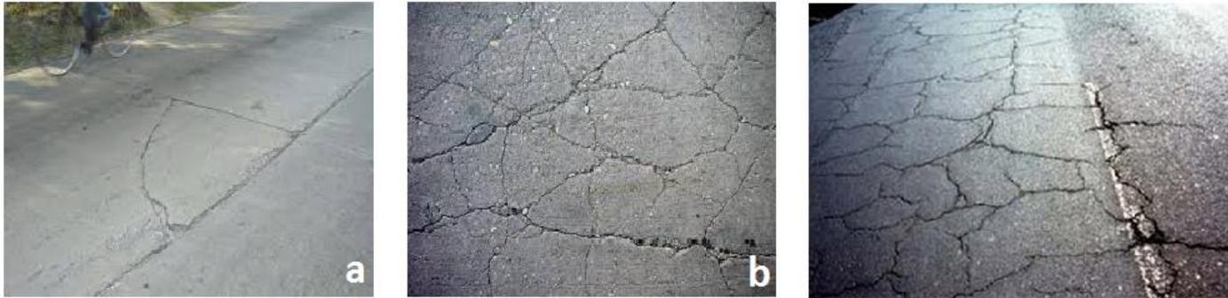
Figura 2.09. Fisuras en Bloque de nivel de severidad bajo (a), medio (b) y alto (c).
