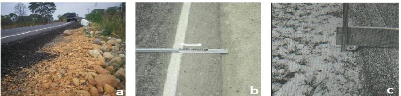
**Figura 2.21. Desnivel Carril - Berma de severidad bajo (a), medio (b) y alto (c).**
