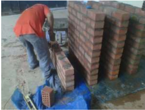
Foto. 10 Control de la junta del murete
