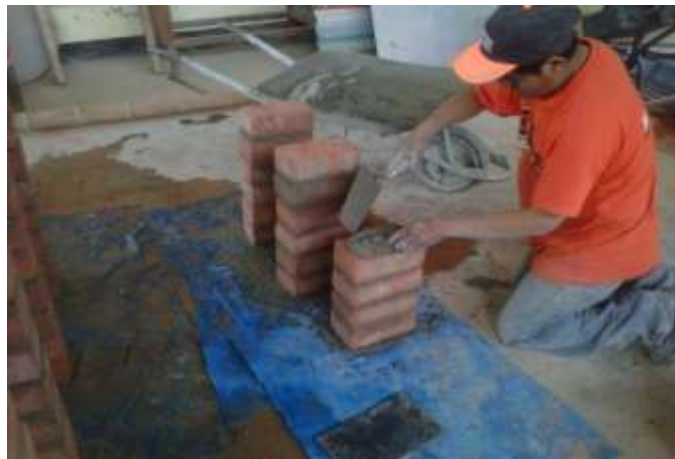
Foto. 8 Construcción de las pilas
