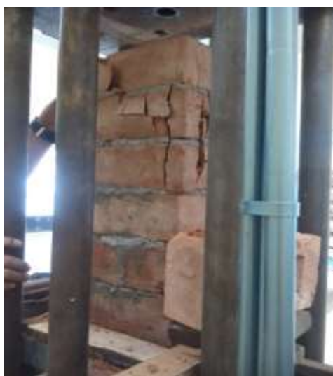
Foto. 9 Falla típica de las pilas de ladrillo
