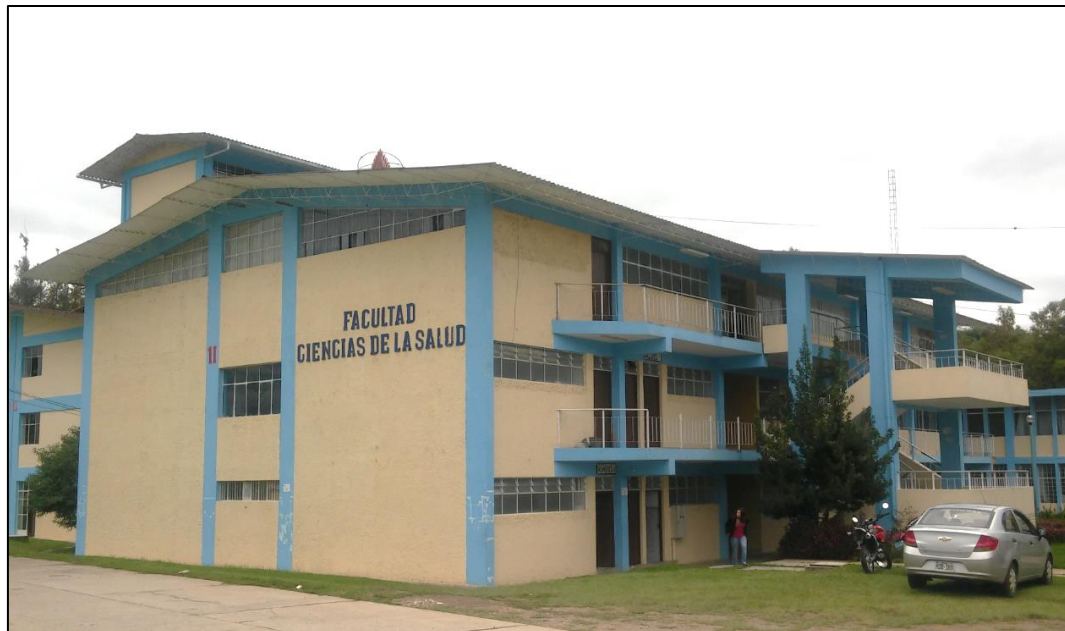
Figura 4.1 Exterior del Edificio 11 – Facultad de Ciencias de la Salud. UNC.
