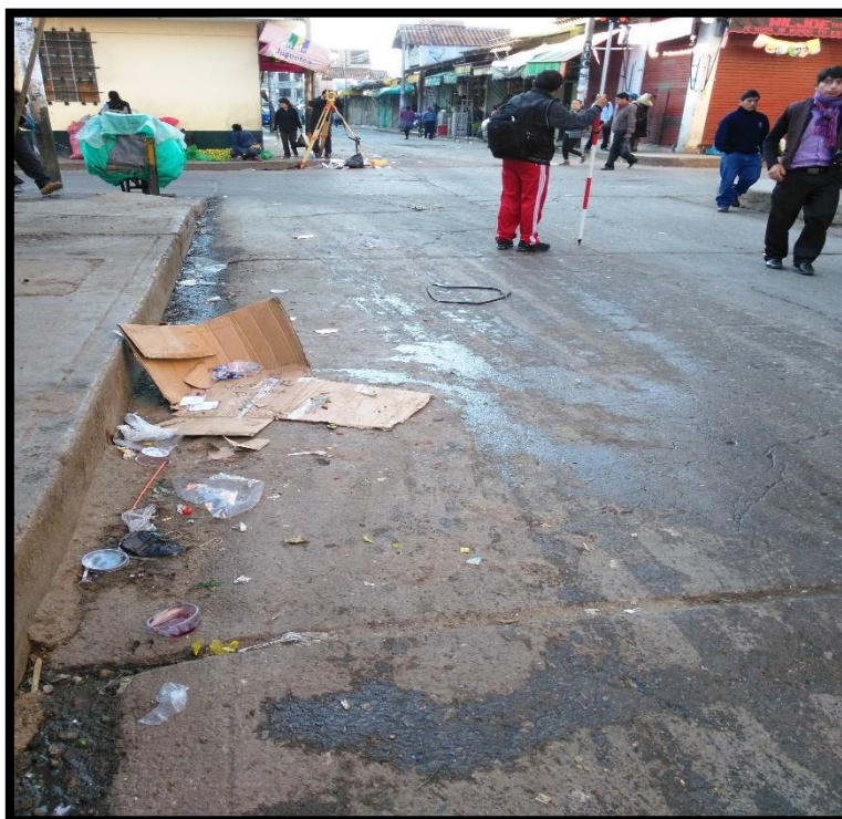
Fotografía N°7: Se observa la toma de puntos en el centro de la vía
