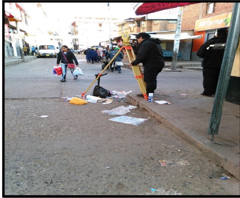
Fotografía N° 5: Se observa el cambio de estación para poder radiar más puntos Jirón Chanchamayo C-20- Km 0 +000
