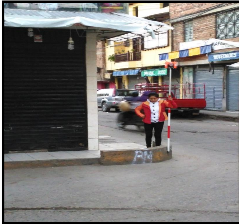
Fotografía N° 3: Se observa la toma del Bm. para poder realizar un posible replanteo.
