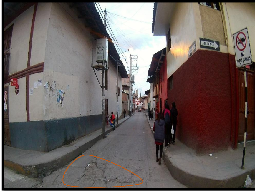
Fotografía N° 20: Se observa el mal estado de la vía Jirón Chanchamayo C1.
