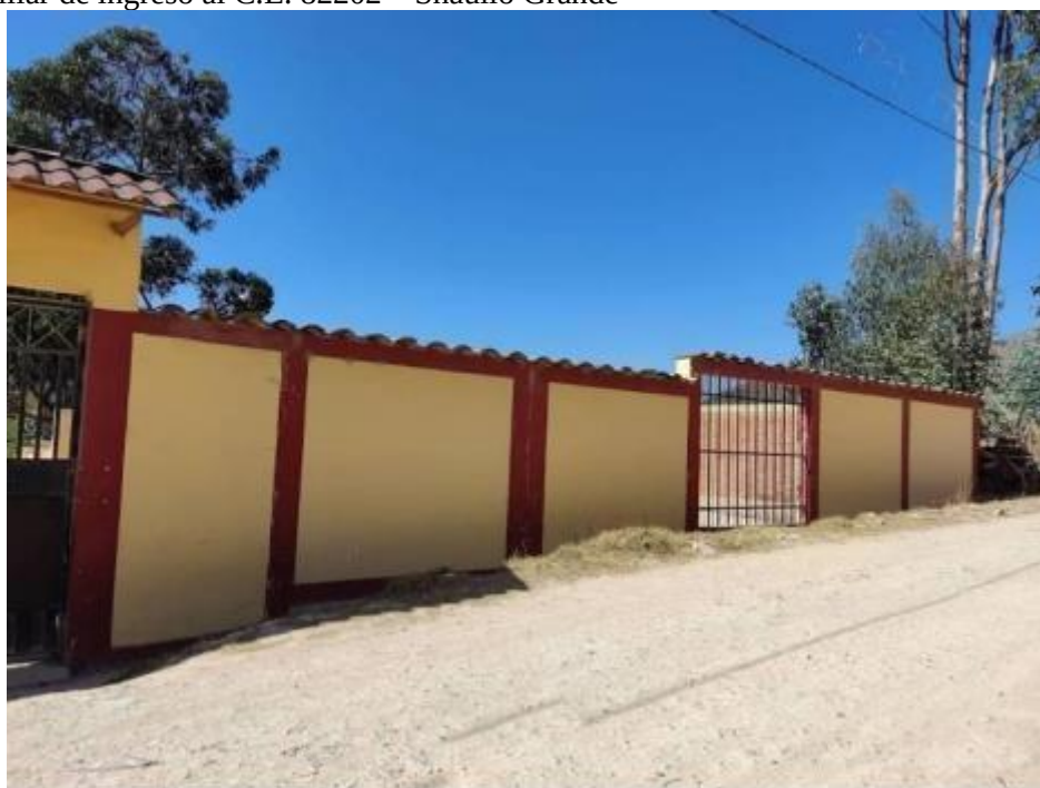
Figura 93: acceso auxiliar de ingreso al C.E. 82202 – Shaullo Grande
