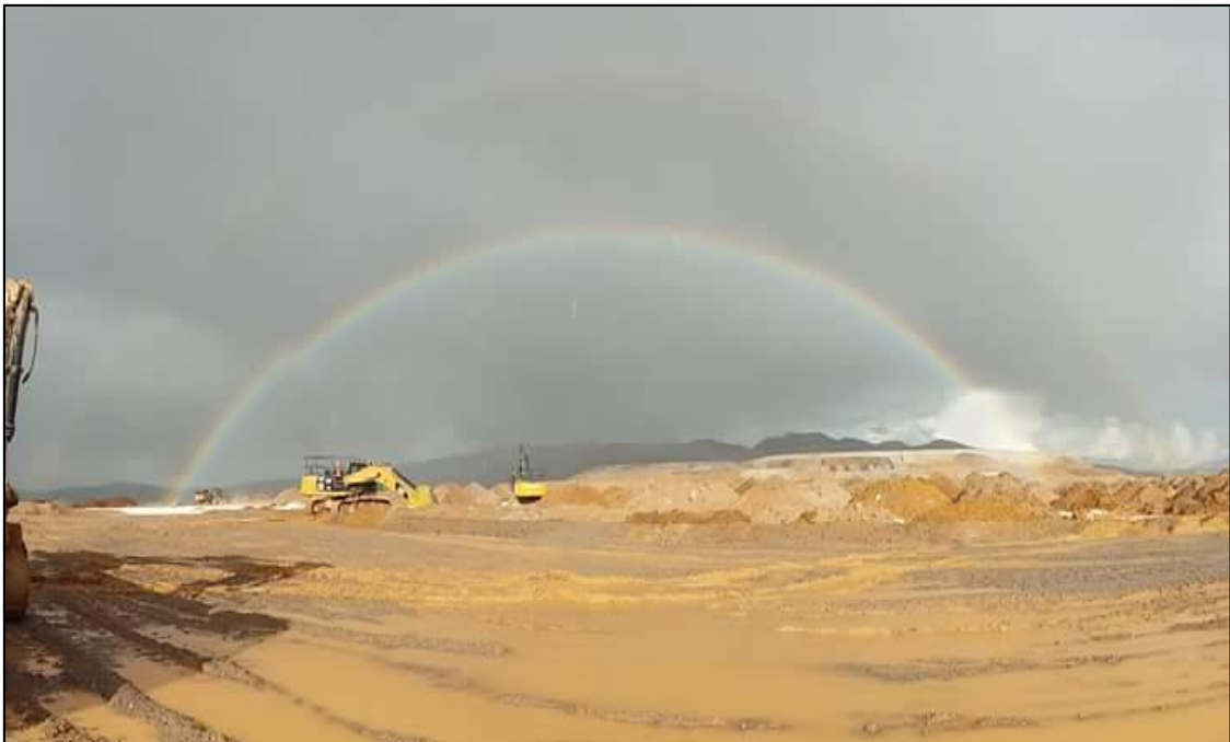
Fotografía N°06: Precipitaciones en Minera Yanacocha.
