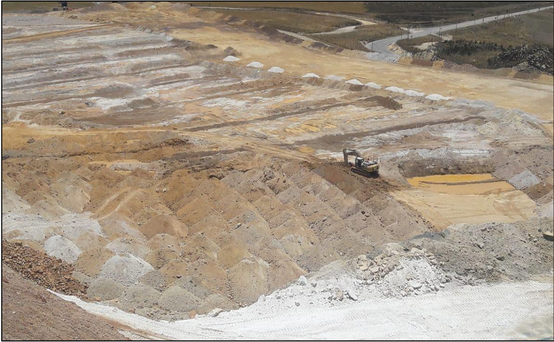
Fotografía N°07: Presencia de charcos en pila de lixiviación.
