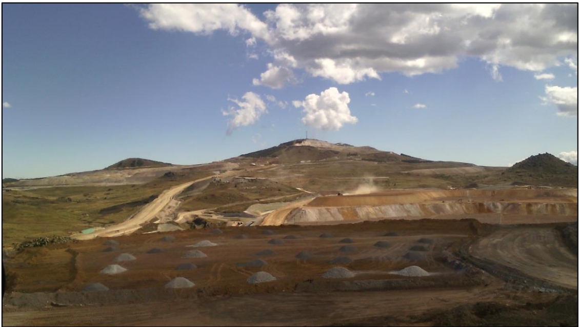
Fotografía N°04: Acumulación de cal en Pila de Lixiviación.
