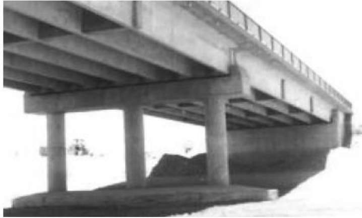
Figura 1. Pilar de columnas múltiples construido sobre tierra. 1
