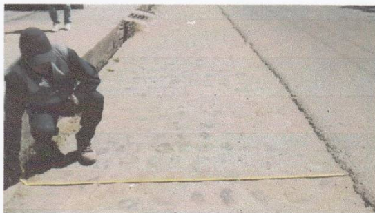
Imagen 5.8 Medición de longitud de berma con wincha metálica
