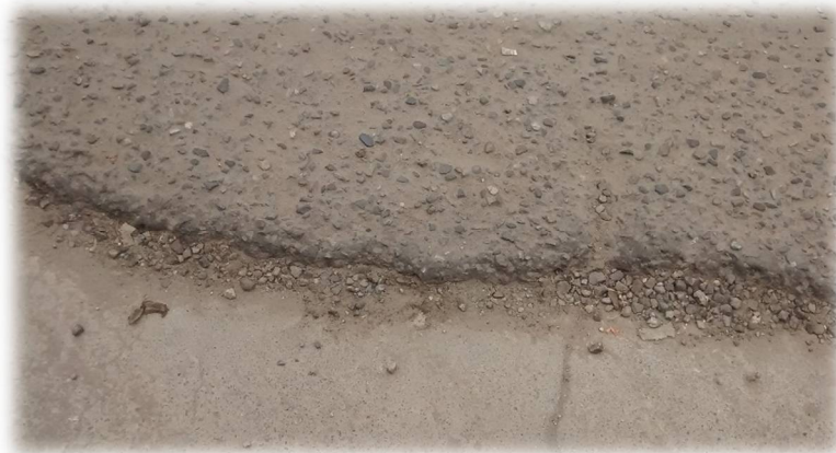
Figura 9. Desnivel carril/berma (Elaboración propia)
