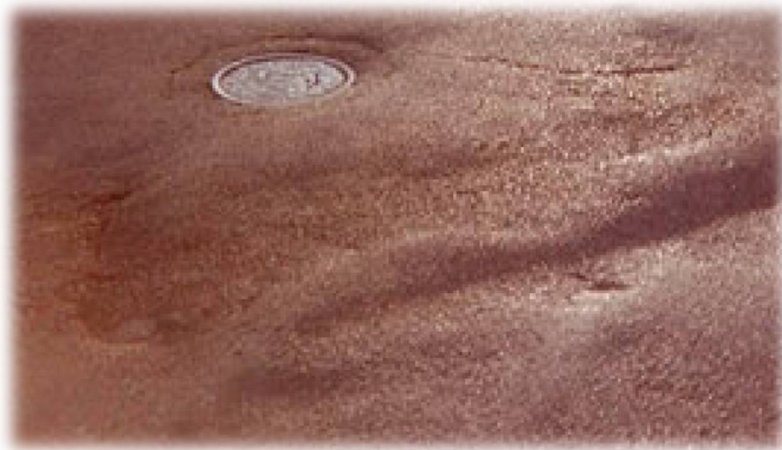
Figura 16. Desplazamiento-(Elaboración propia)
