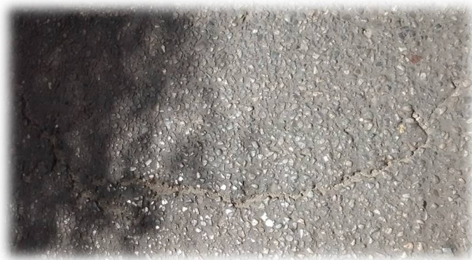
Figura 4. Abultamiento-Elaboración propia
