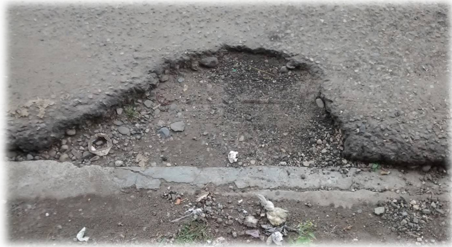
Figura 7. Grieta de borde. (Elaboración propia)
