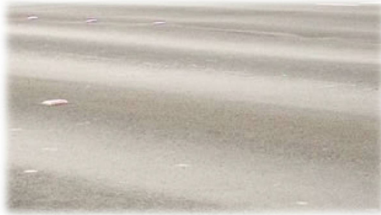
Figura 15. Ahuellamiento-(Elaboración propia)
