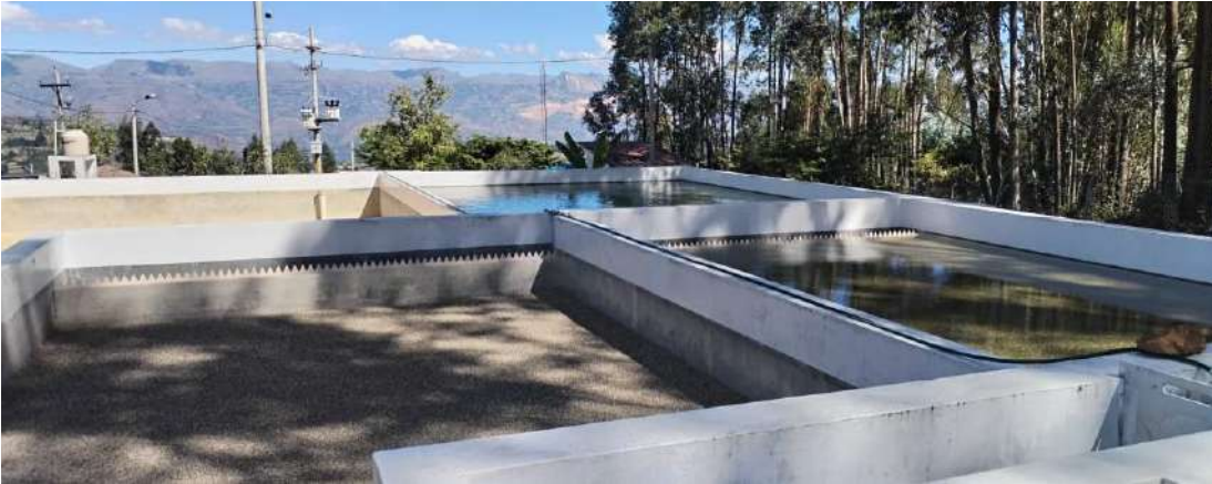
Figura N°24: Visita al reservorio.
