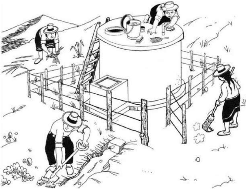
Figura N°9: Limpieza externa del reservorio
