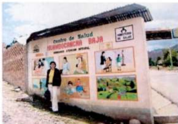
Ingreso al CC.SS. Huambocancha Baja-2015
