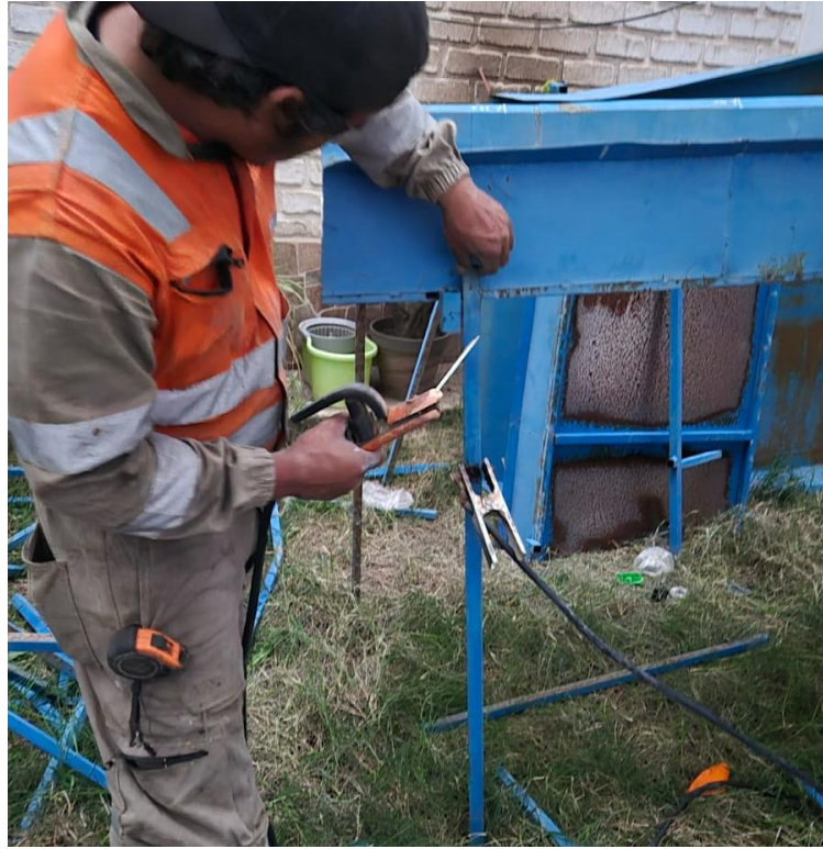
Figura 65: Construcción de la estructura metálica del modelo físico.
