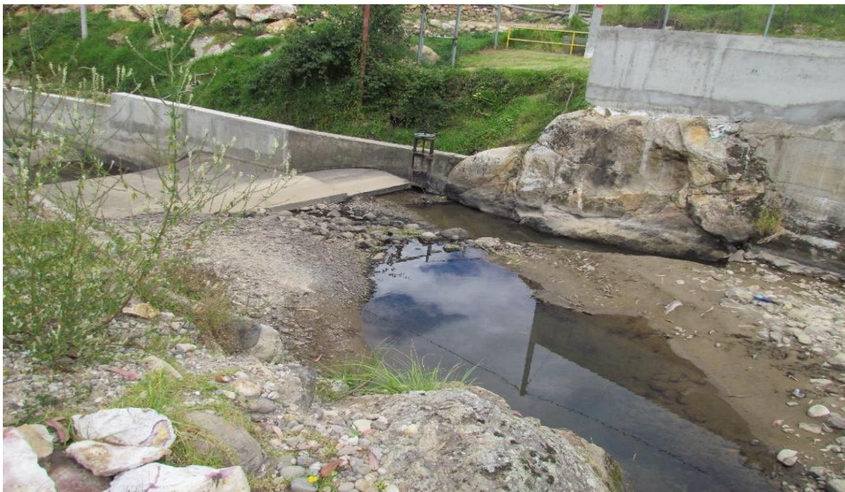
Figura 48: Bocal de la segunda captación aguas abajo de la captación “Río Porcón”.
