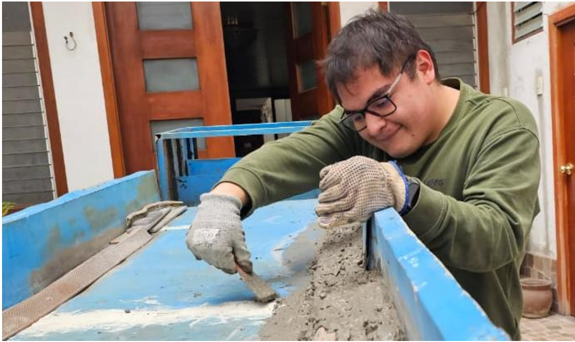
Figura 69: Revestimiento de las paredes laterales del modelo físico con mezcla de concreto.
