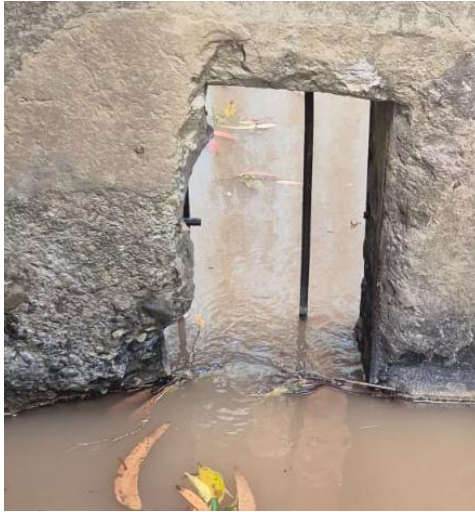
Figura 36: Vista del bocal de captación ampliado tras intervención por la EPS.
