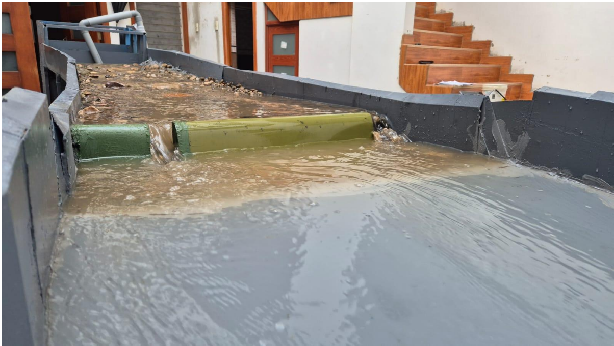
Figura 77: Apertura del 20% del barrage fusible.
