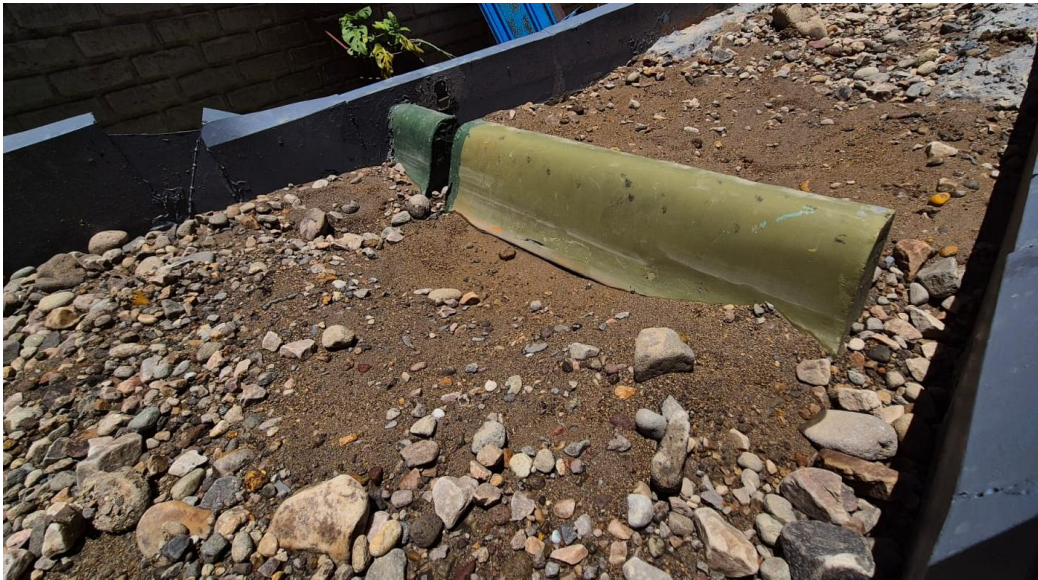
Figura 40: Estado final de la captación tras descolmatación inducida.
