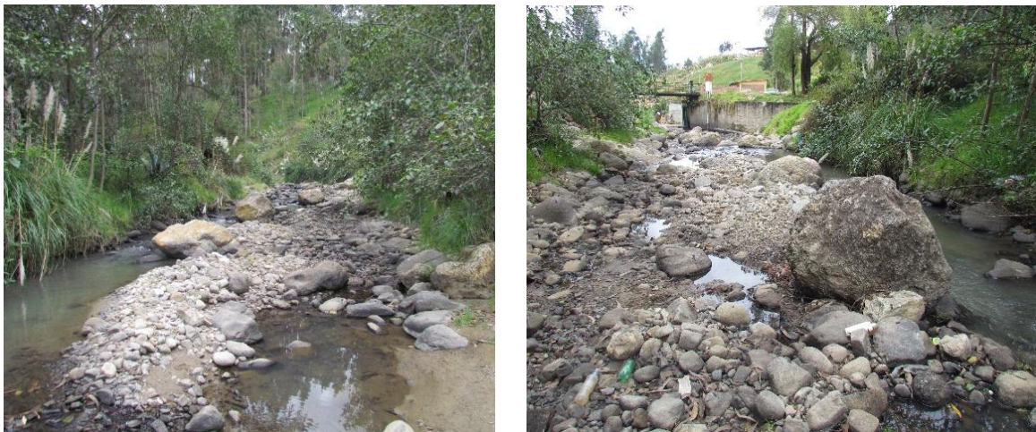
Figura 18: Colmatación aguas arriba del barrage de la captación derivadora.
