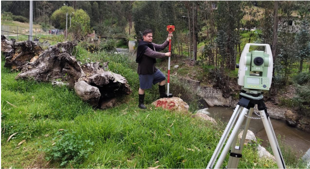
Figura 51: Establecimiento del segundo punto de control (BM) durante el levantamiento topográfico.
