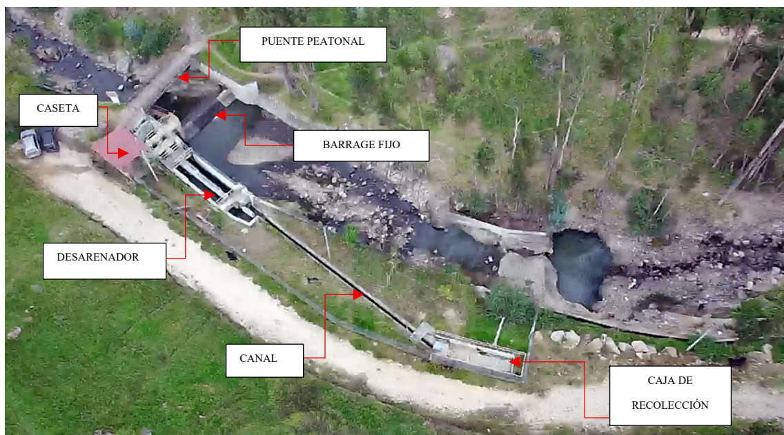
Figura 16: Vista elevada de las partes de la captación derivadora del río Porcón.
