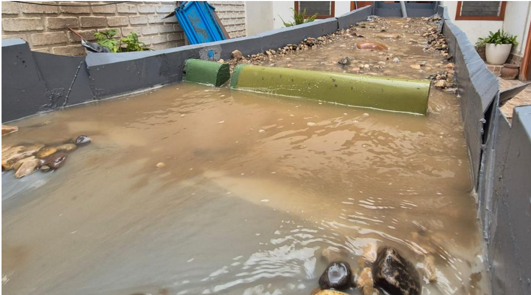
Figura 39: Perfil de poza disipadora y cambio de pendiente aguas abajo.
