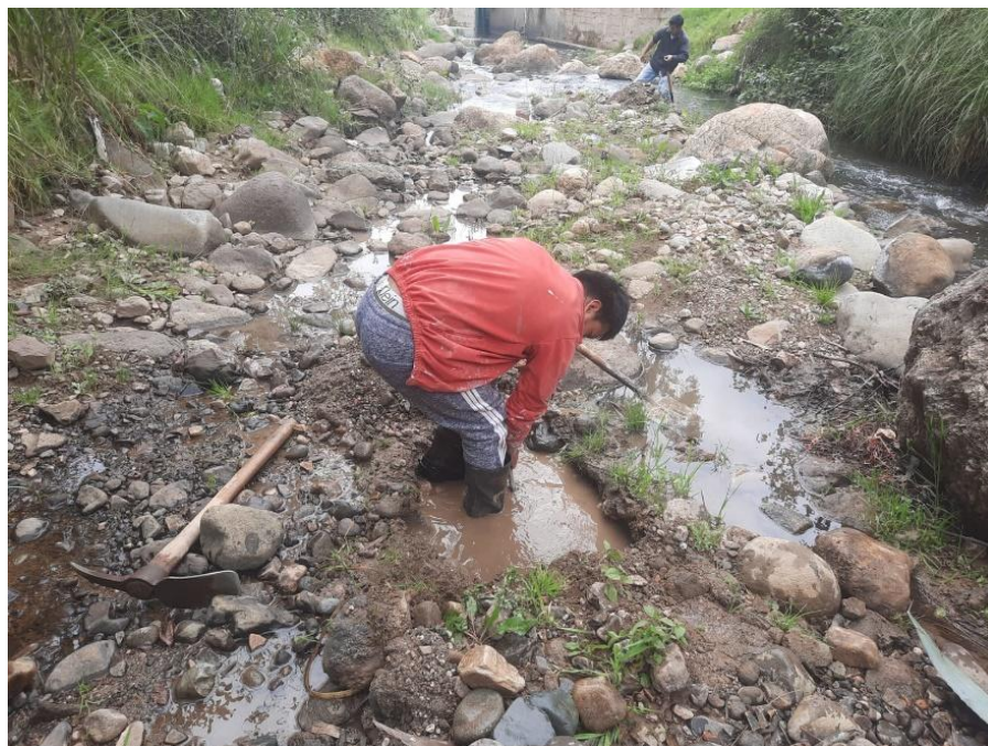
Figura 54: Excavación de calicatas aguas arriba del barrage.
