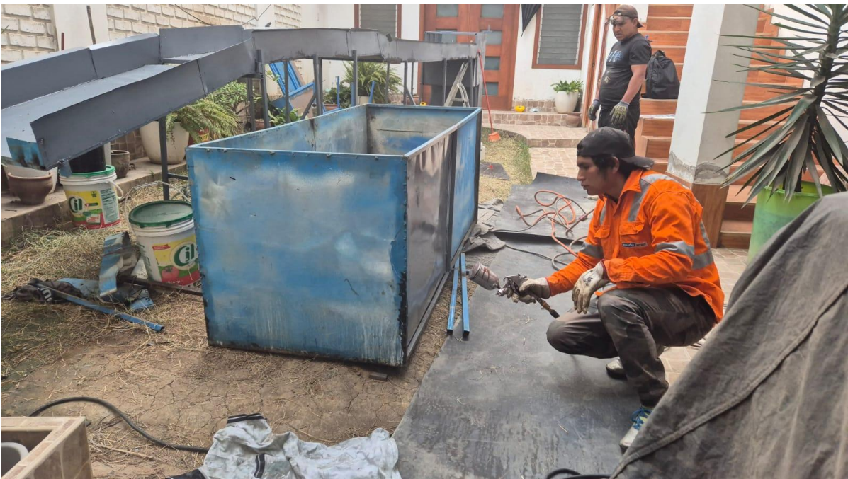
Figura 70: Trabajos de pintura y acabado superficial del modelo físico previo a pruebas hidráulicas.
