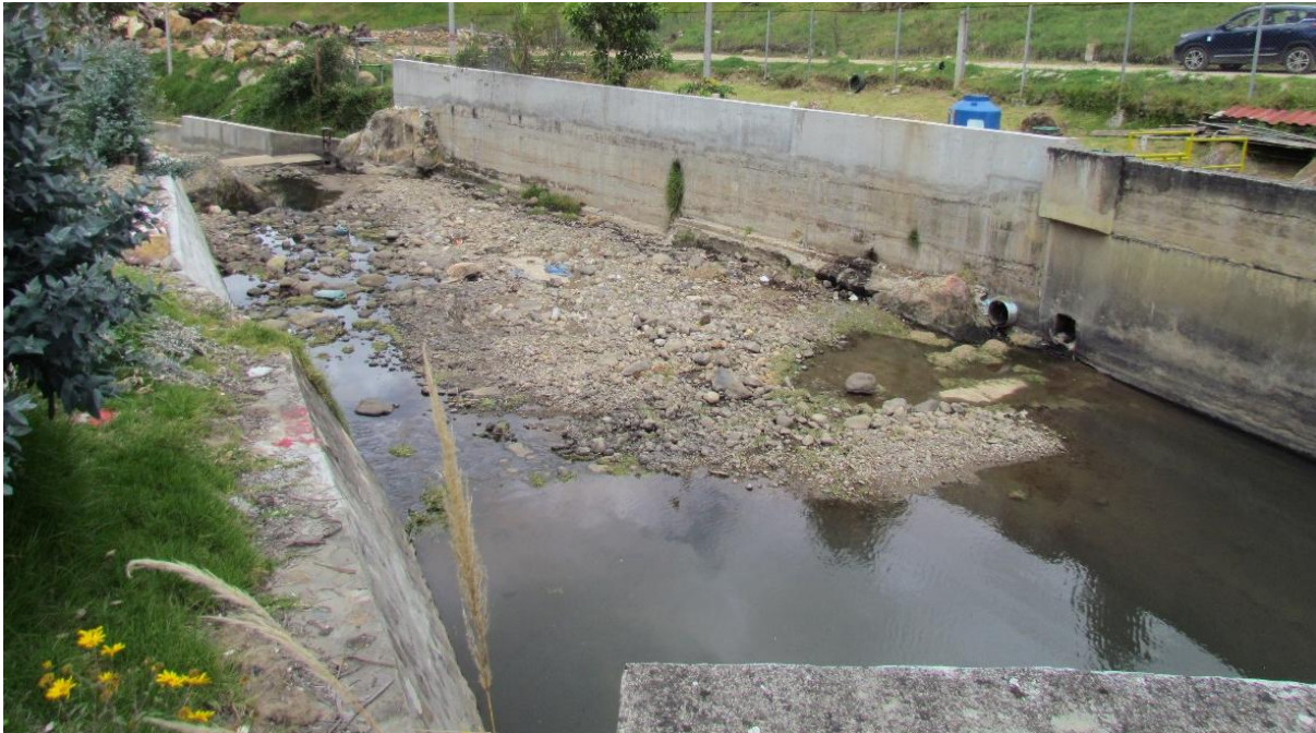
Figura 47: Sedimentos superficiales aguas abajo de la captación “Río Porcón”.
