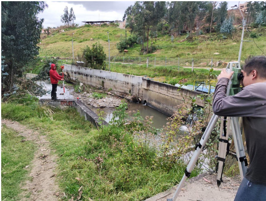
Figura 50: Establecimiento del primer punto de control (BM) durante el levantamiento topográfico.
