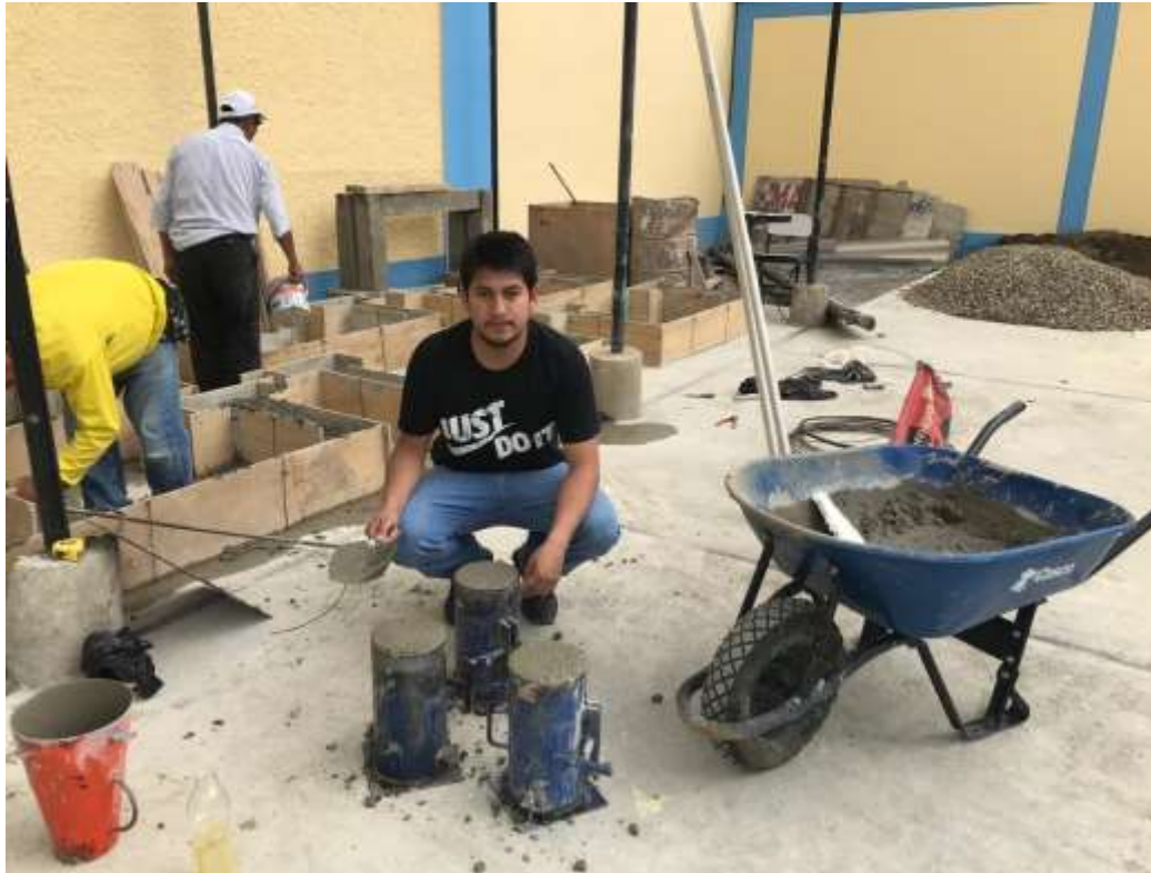
Fotografía 3. Llenado de tres testigos para un concreto con f'c=210 \text{ kg/cm}^2 .
