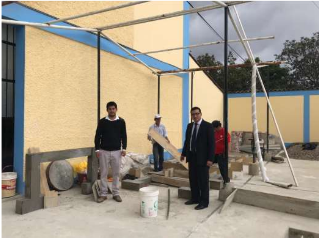
Fotografía 5. Desencofrado de pórticos de concreto armado.
