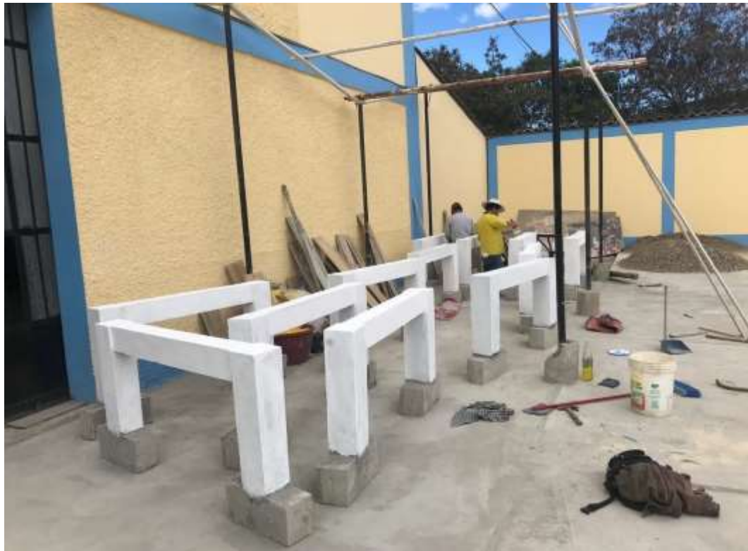
Fotografía 7. Colocación de base en los pórticos de concreto armado.
