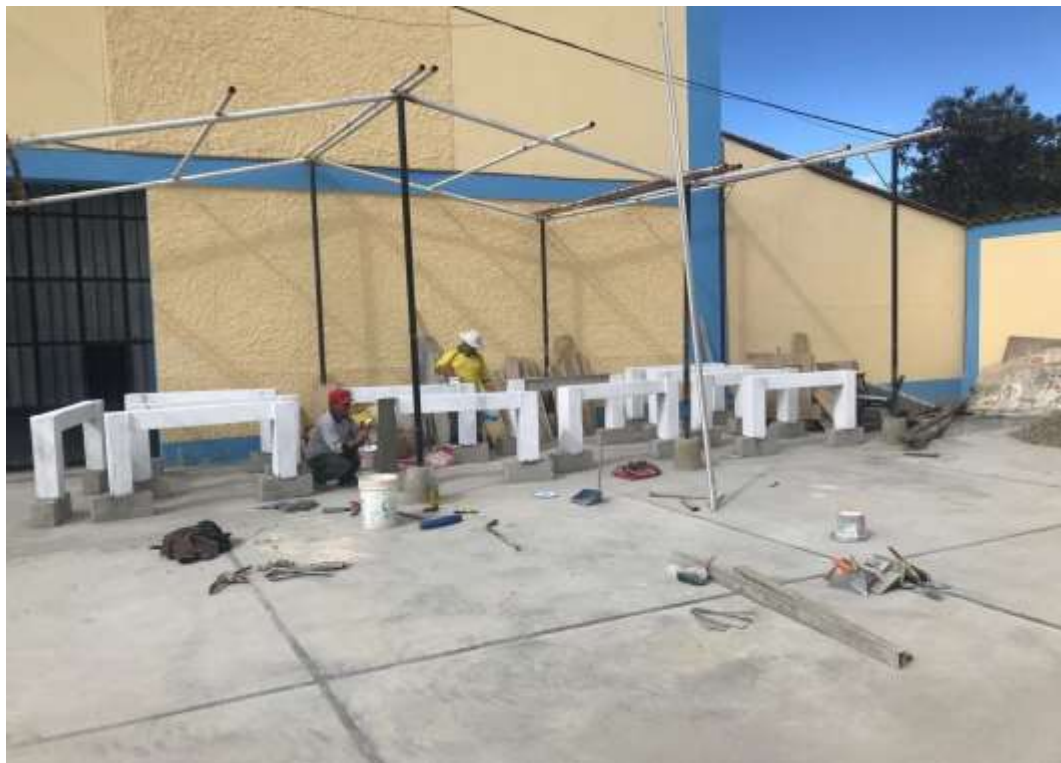
Fotografía 8. Vista general de todos los pórticos de concreto armado.
