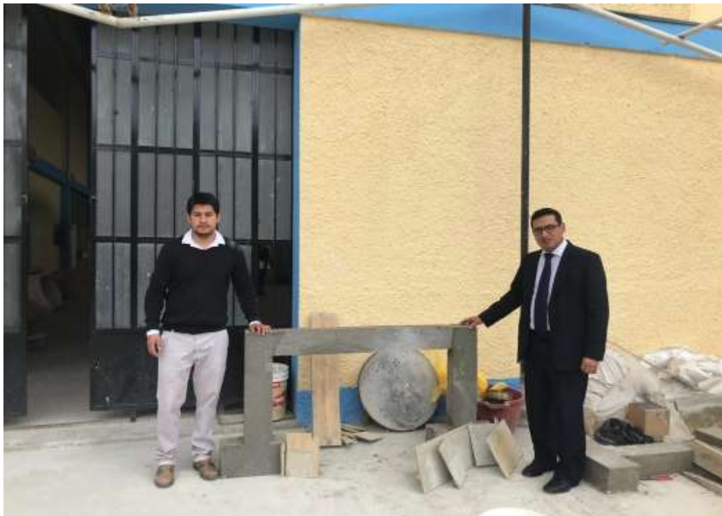
Fotografía 6. Asesor supervisando los pórticos después de desencofrarlos.
