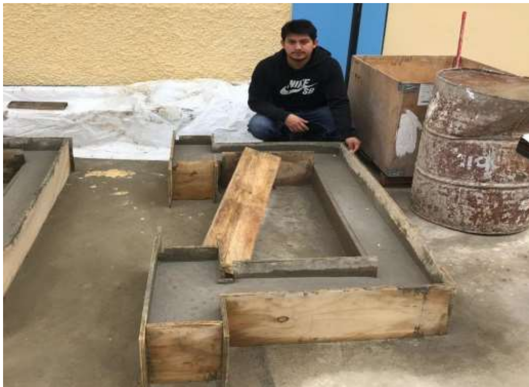
Fotografía 4. Curación de pórticos de concreto armado con f'c=210 \text{ kg/cm}^2 .
