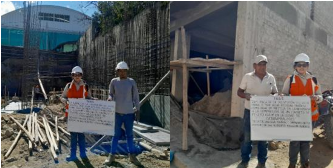
Realización de la encuesta en las obras de construcción en la ciudad de Cajabamba
