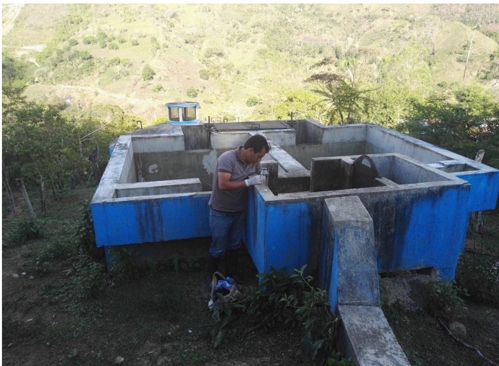
Foto N° 06: En la toma de muestra en los filtros lentos.
