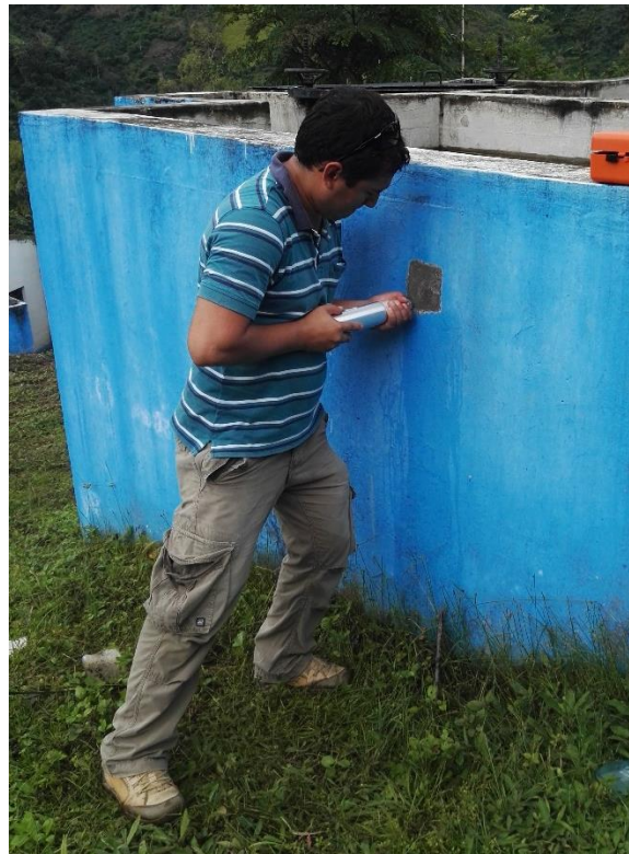
Foto N°: 08: Realizando el ensayo de Esclerometría.
