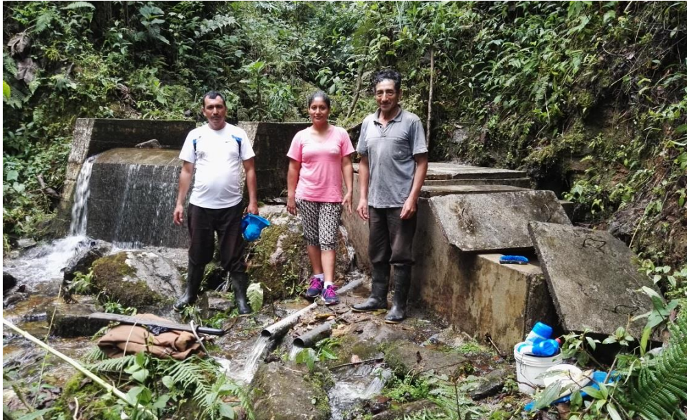
Foto N° 01: Fotografía de la captación.
