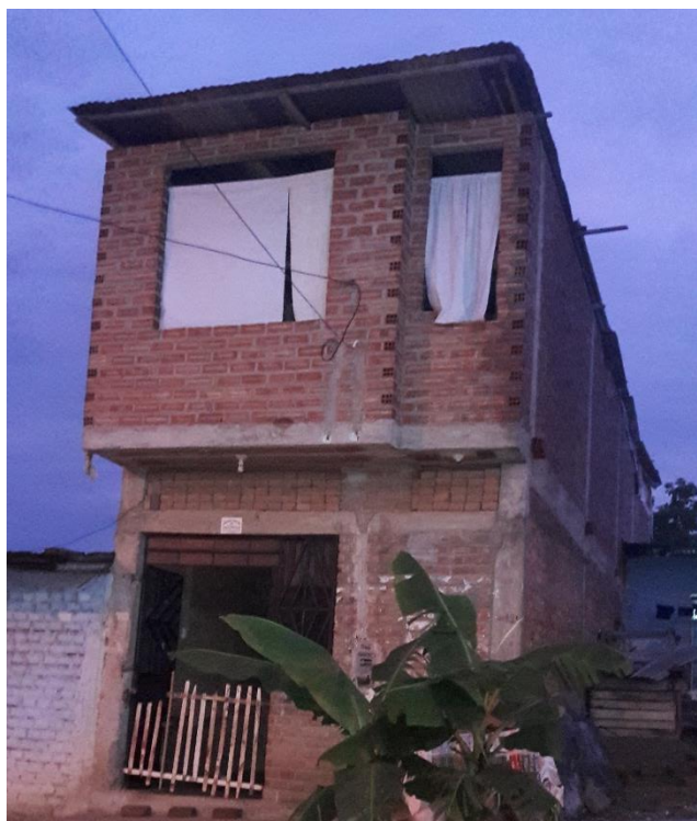
Figura N° 16. Vivienda construida con Ladrillo Pandereta
