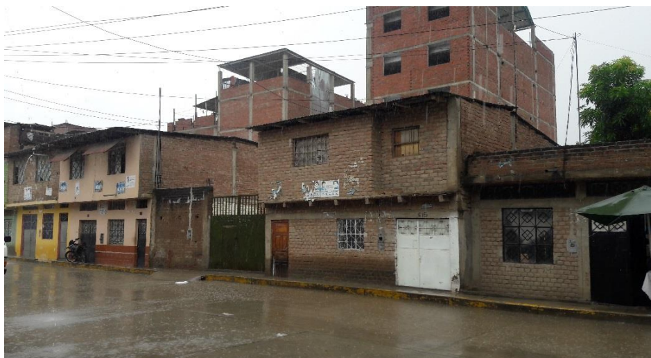
Figura N°8. Viviendas propensas a inundaciones
