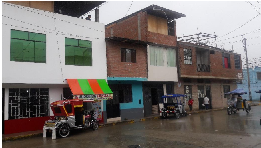
Figura N°9. Viviendas sin Junta Sísmica y Losas a Desnivel
