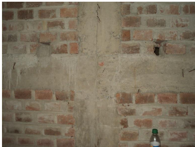
Fotografía 2. Interior de una vivienda de albañilería artesanal
