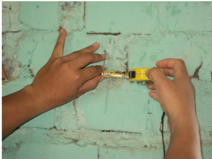
Fotografía 8. Juntas de 5cm en muros.
