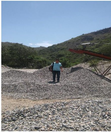
Figura 28. Acopio de materiales.
