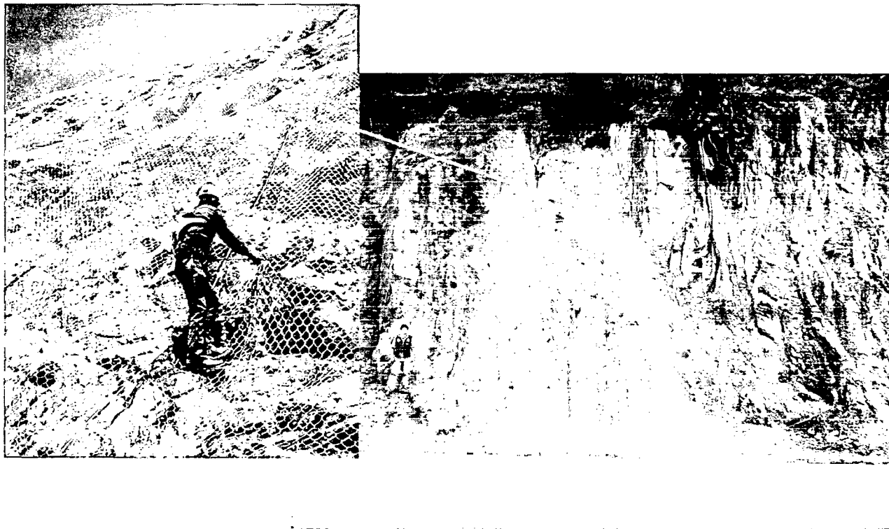
Foto. 29 Estabilización en la progresiva Km 165+700 – Km 165+850.
