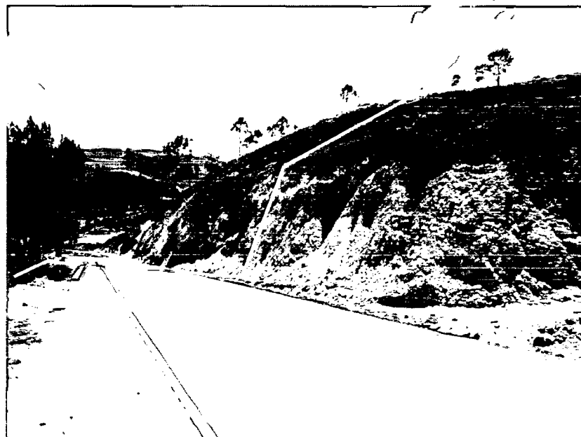
Foto. 20 Afloramiento de calizas margosas en la progresiva Km 167+070 – Km 167+210, altamente alterado, compuesto por intercalaciones de lutitas y calizas de textura packstone.
