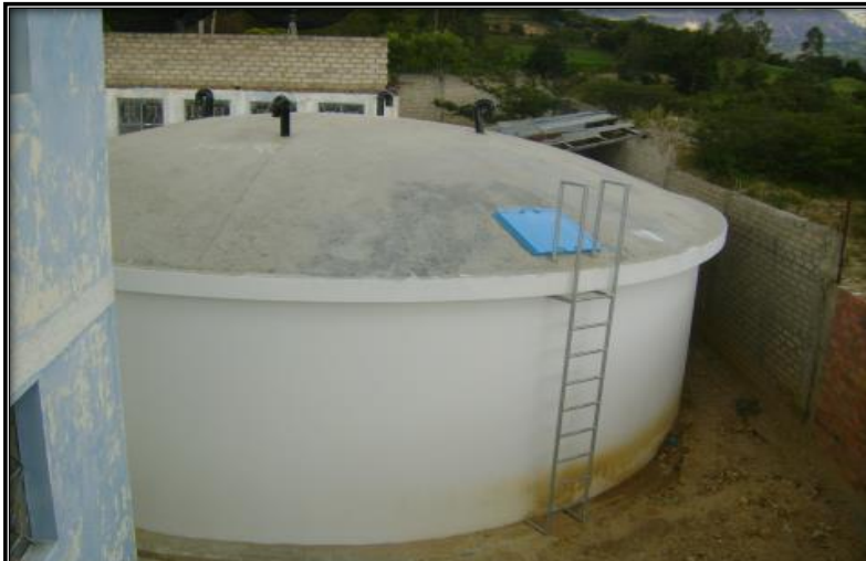
Figura 134: Reservorio San Marcos.
