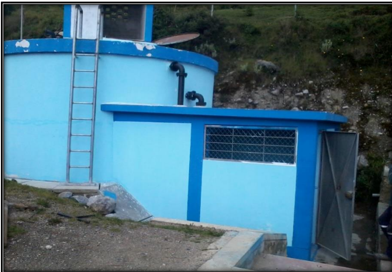
Figura 141: Reservorio de 50 m 3 , El Mirador – Hualgayoc. Concluido
