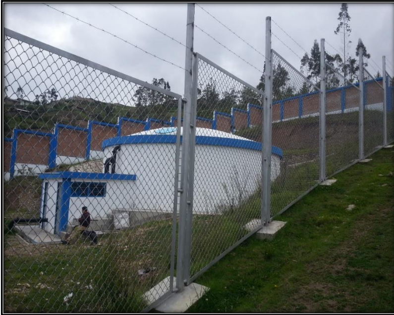
Figura 143: Reservorio R4 de 230 m3 Bambamarca. Concluido.
