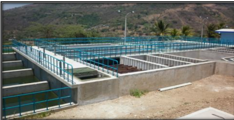
Figura 150: Planta de Tratamiento de Agua Potable (PTAP) Jaén. Concluido.
