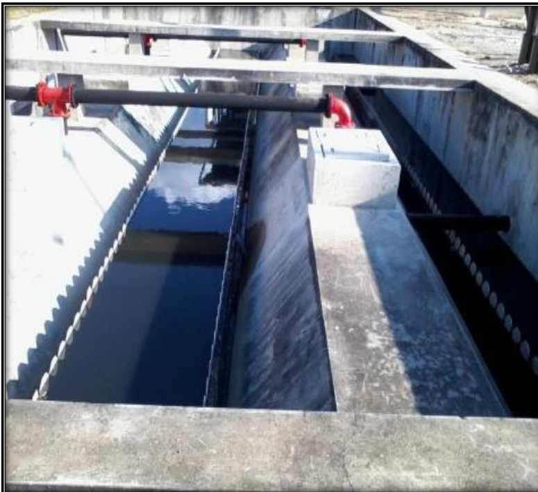
Figura 130: PTAR Celendín. Concluido
