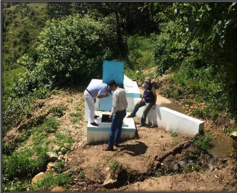
Figura 138: Captación Monte grande – Contumaza
