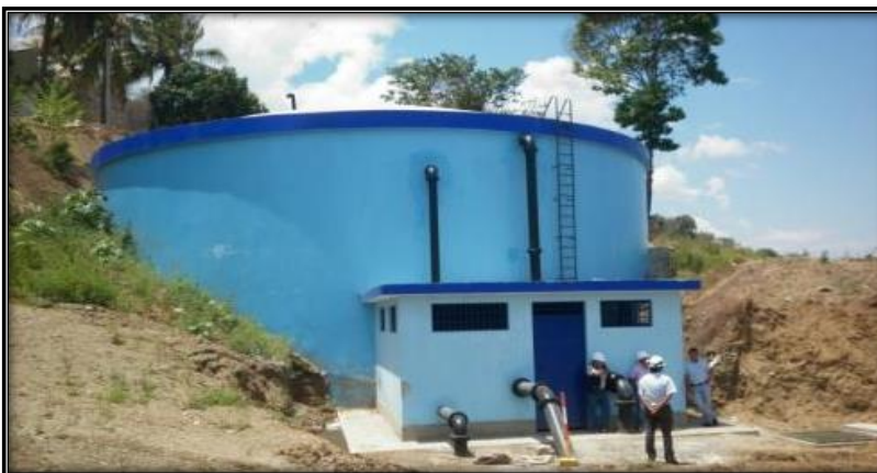
Figura 151: Reservorio La Planta de 1600 m3 – Jaén. Concluido
