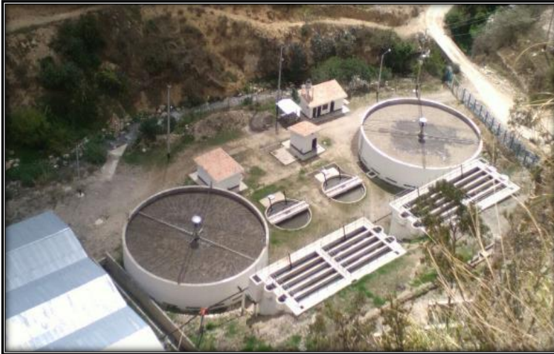
Figura 126: Planta de Tratamiento de Aguas residuales 1 (PTAR 1) de Cajabamba. Concluido.
