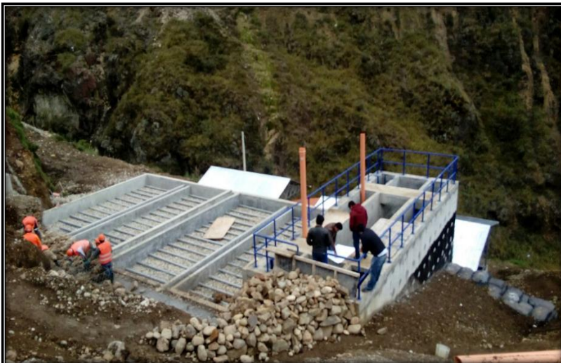
Figura 142: Planta de Tratamiento de Aguas residuales Hualgayoc. Inconclusa
