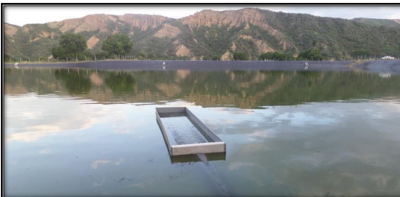
Figura 152: Laguna de la Planta de Tratamiento de Aguas Residuales – Jaén. Concluido
