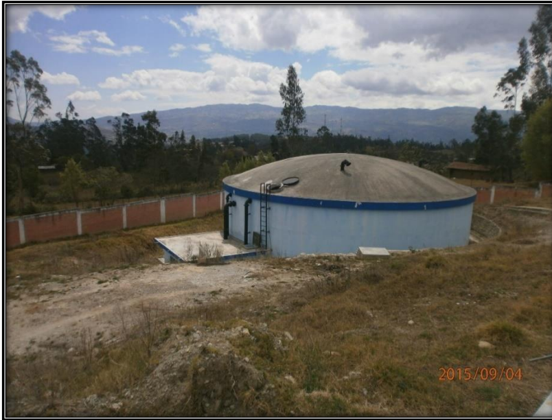
Figura 145: Reservorio de 1,100 m 3 en la PTAP– Chota. Concluido.
