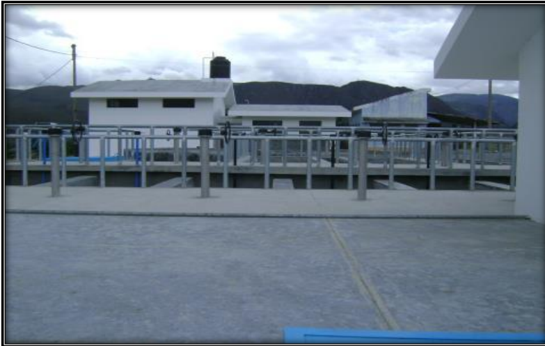
Figura 133: Planta de Tratamiento de Agua Potable (PTAP) San Marcos. Concluido
