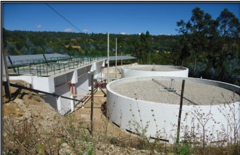
Figura 127: Planta de Tratamiento de Aguas residuales 2 (PTAR 2) de Cajabamba. Concluido
