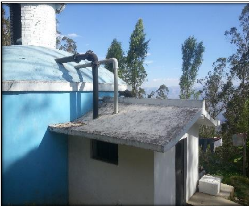
Figura 137: Mejoramiento de la caseta del Reservorio San Pablo.
