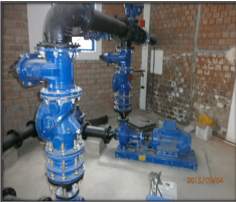
Figura 144: Sistema de Bombeo de R2 al R4
