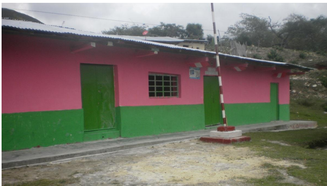
I.E. N° 17525 del caserío Nueva Esperanza de Chingama, después de las acciones de mantenimiento, año 2014.
