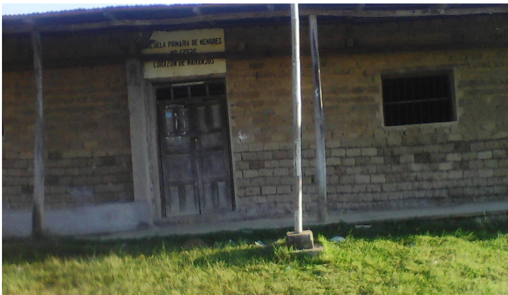
I.E. N° 17526 del caserío del Corazón del Naranjo de Chingama, anterior a las acciones de mantenimiento, año 2007.
