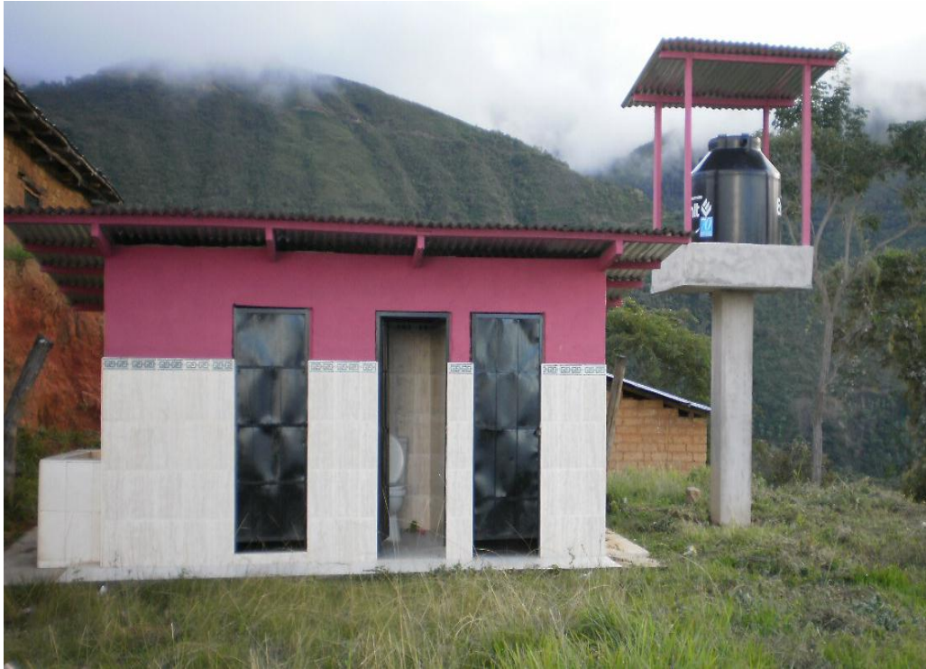
SS. HH., y tanque elevado en la I.E. N° 16078 del caserío Laurel de Chingama, después de las acciones de mantenimiento, año 2014.
