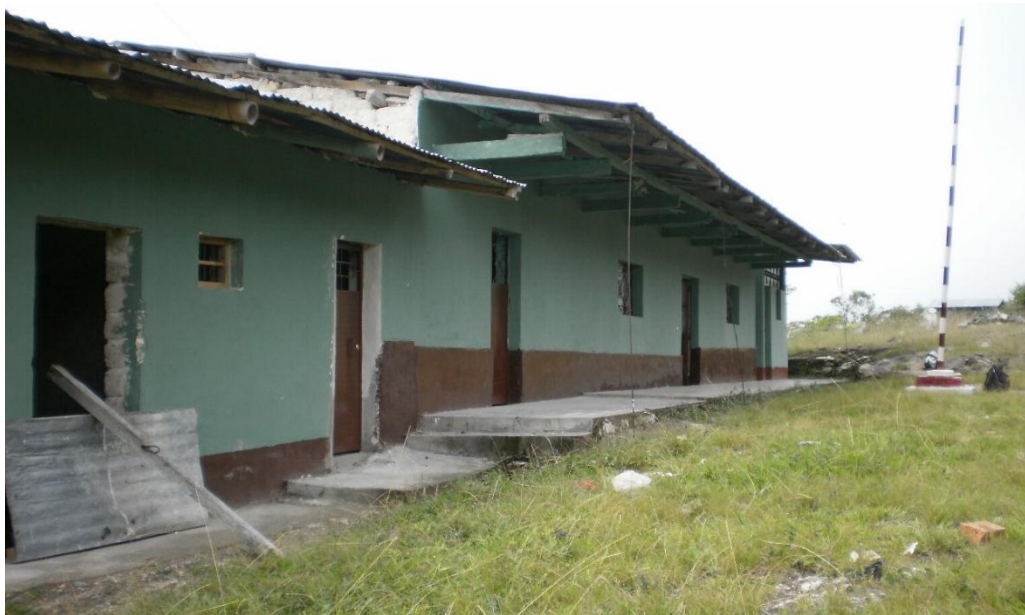
I.E. N° 17528 del caserío de Buenos Aires de Chingama, anterior a las acciones de mantenimiento, año 2011 (segunda etapa).
