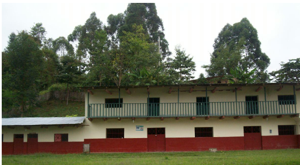
I.E. N° 17427 del caserío del Palto de Chingama, después de las acciones de mantenimiento, año 2014.
