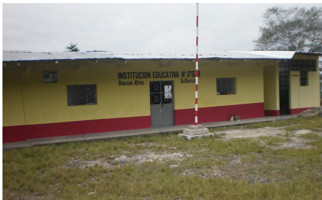
I.E. N° 17528 del caserío de Buenos Aires de Chingama, después de las acciones de mantenimiento, año 2014.
