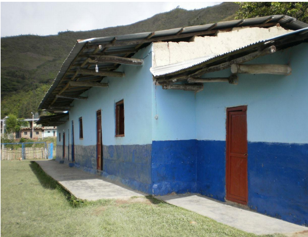
I.E. P. y S. N° 16673 del caserío Gramalotal de Chingama, después de las acciones de mantenimiento, año 2014.
