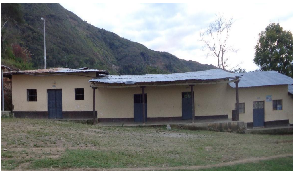
I.E. N° 16805 del Caserío de Altamisa de Chingama, anterior a las acciones de mantenimiento, año 2009
