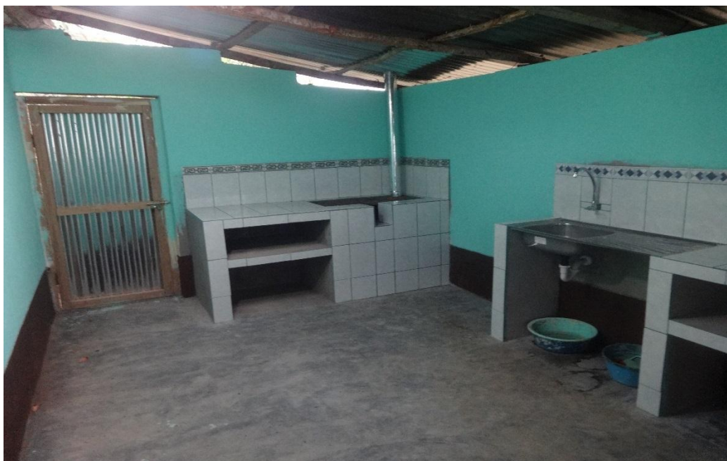
Interior de un ambiente destinado a la preparación de los desayunos escolares del programa de Qali warma, después de las acciones de mantenimiento, en la I.E. N° 16805 del caserío de Altamisa de Chingama, año 2014.
