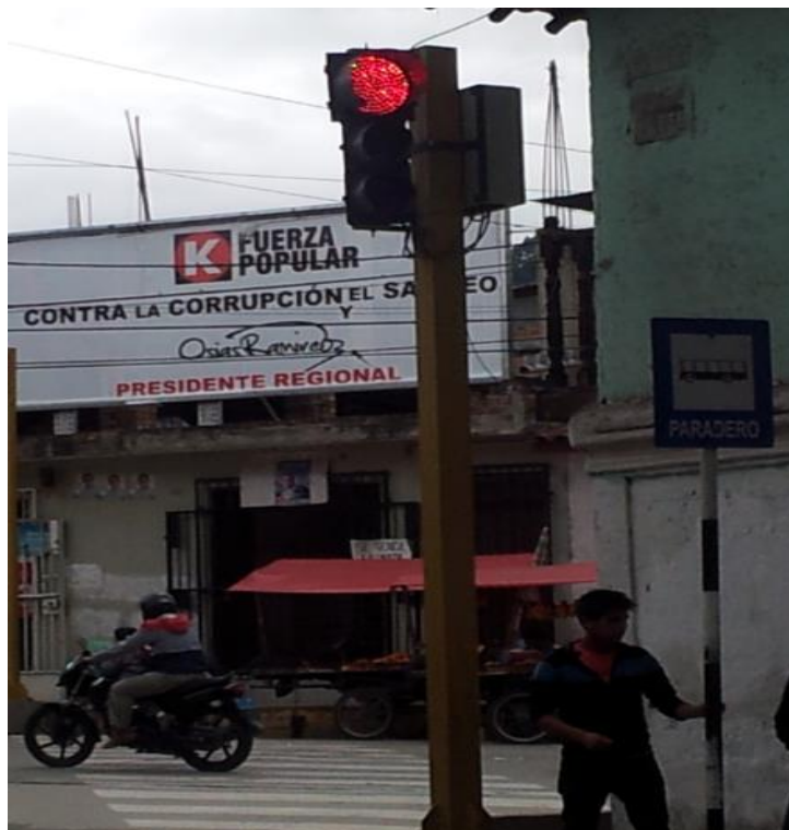
Toma fotográfica N° 10: Verificación de ubicación de dispositivos de control (Semáforo)
