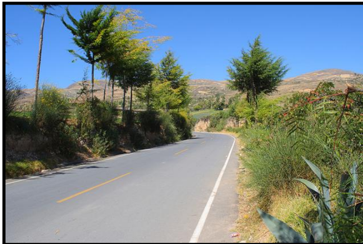
Fotografía N° 07: Vía Interurbana (Carretera Cajamarca-Jesús).
