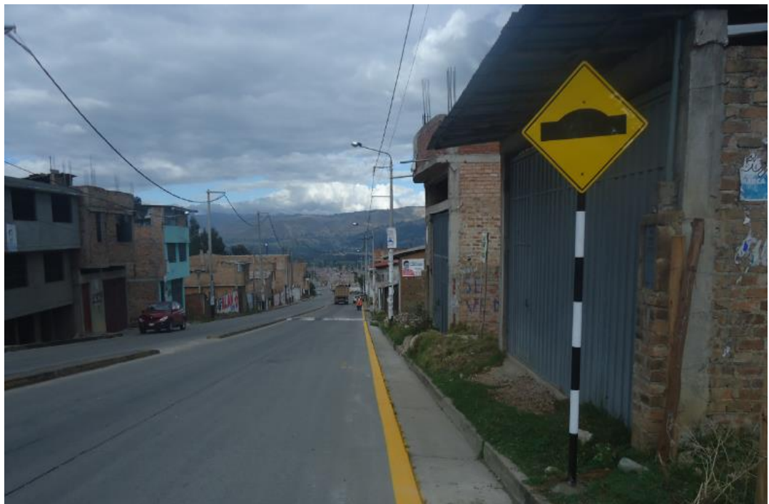
Toma fotográfica N° 12: Verificación de ubicación de dispositivos de control (Señalización vertical) en Av. Héroes del Cenepa.
