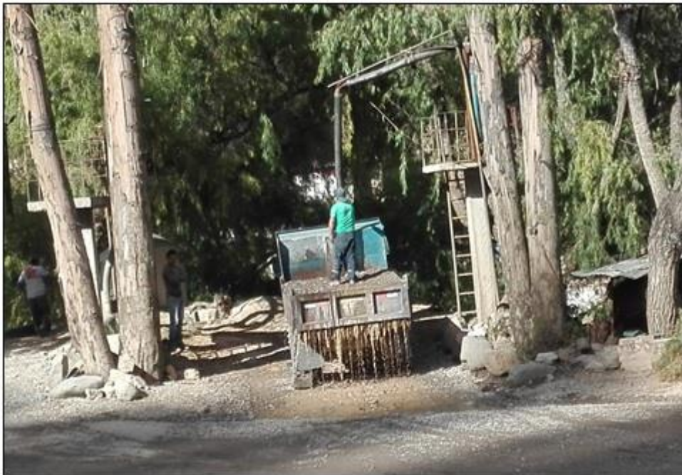
Foto 02: Lavado de agregados para un mejor trabajo de los mismos.
