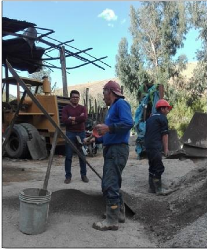
Foto 03: Tamizado de la arena por el tamiz 5/16 para que cumpla con el huso granulométrico.
