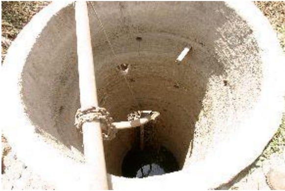
Figura A.1: Pozo zona San Martín
