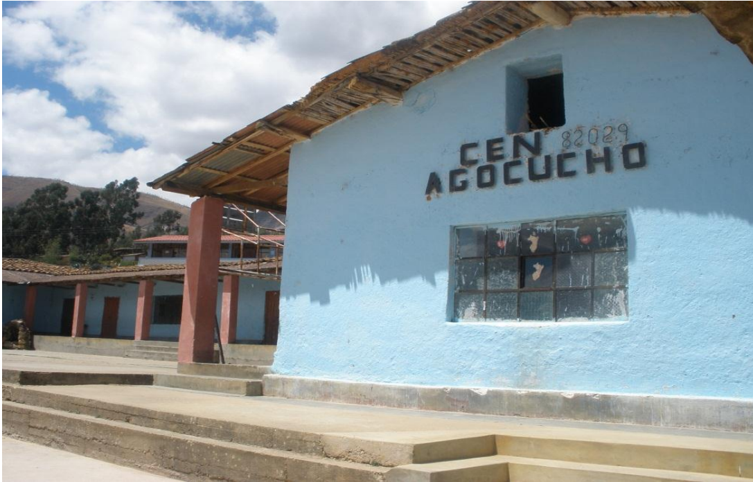
Fachada del Centro Educativo N° 82029 - Agocucho
