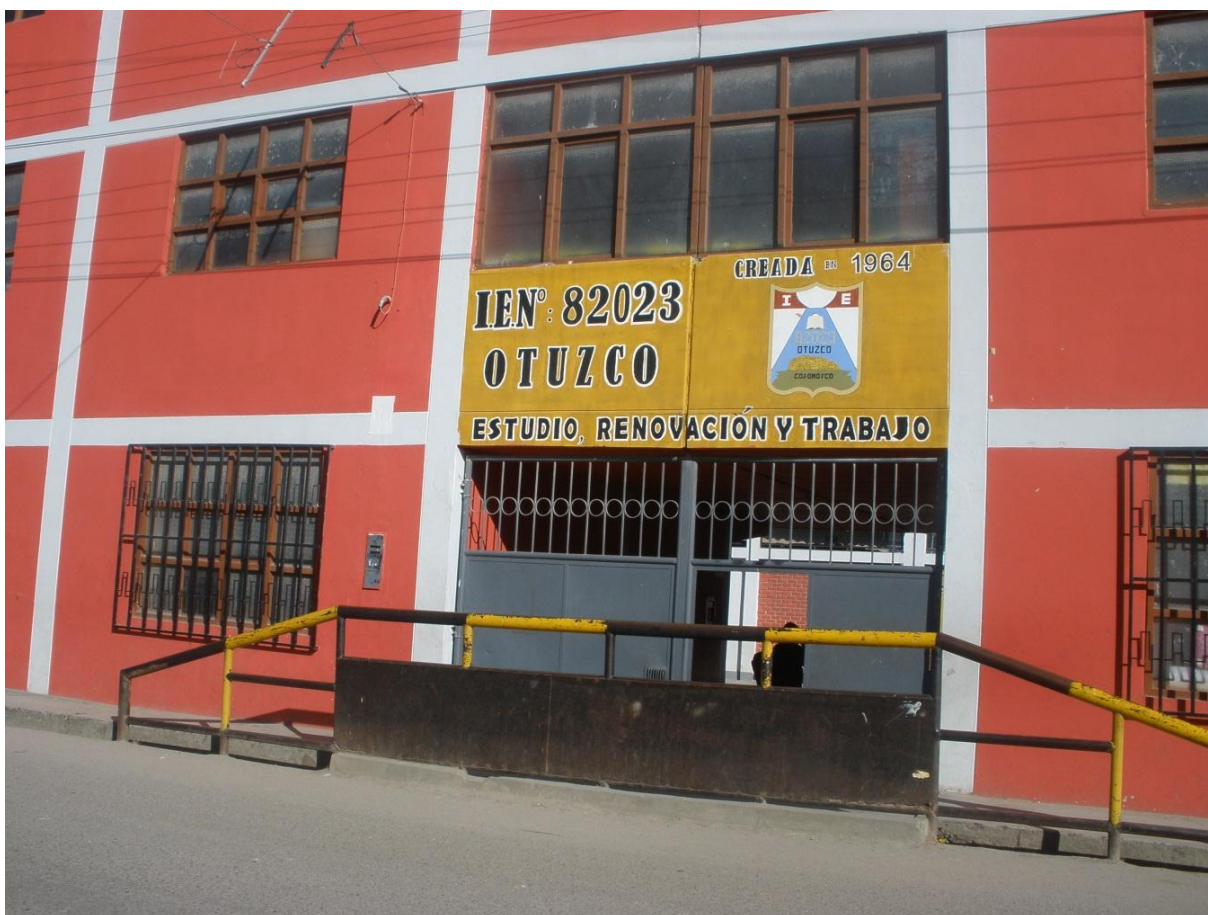
Fachada de la Institución Educativa N° 82023 – Otuzco Alto
