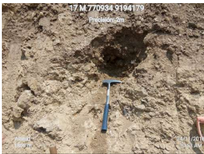
Foto 11. Estación de control Geomecánico N° 03, en suelo del deslizamiento el Naranjo.
