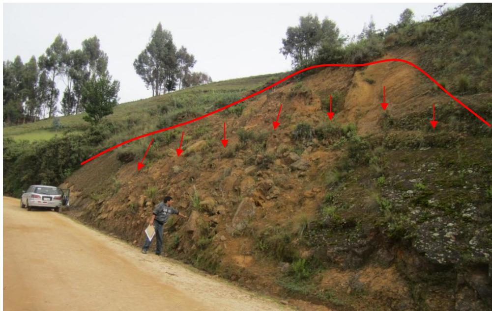
Foto 2. Movimiento complejo de suelos, generado en el contacto de las rocas de la formación Inca y la formación Chulec. Foto tomada al pie de la carretera a Chamis.
