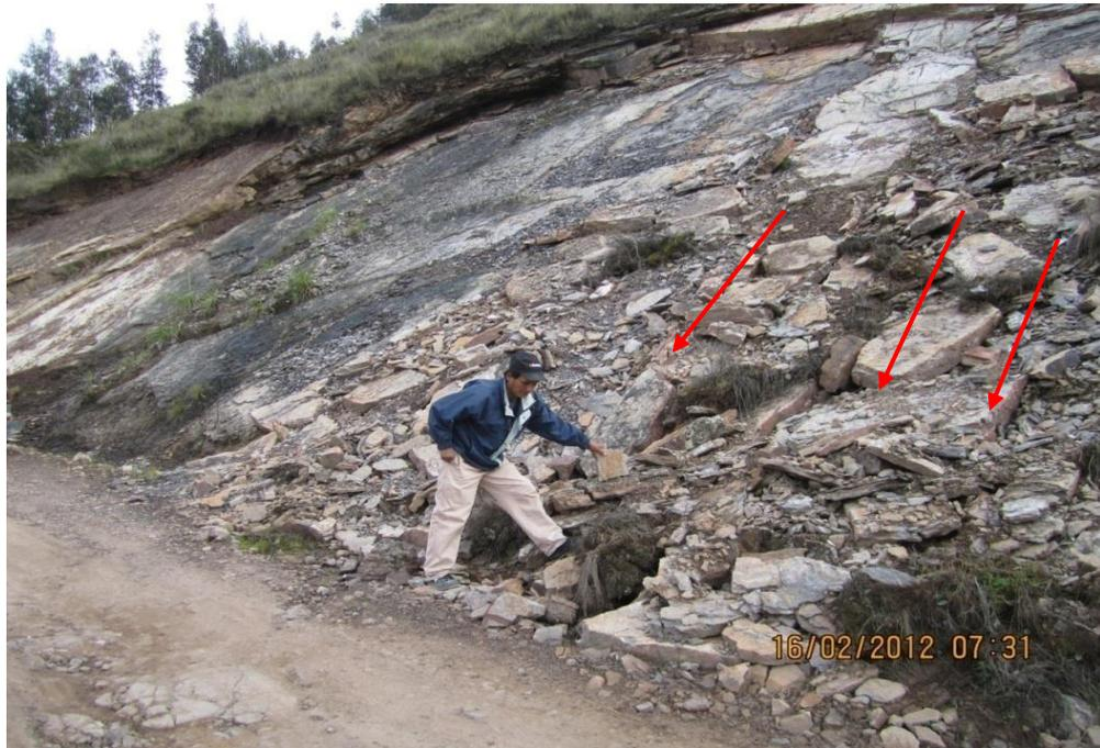
Foto 1. Caída de rocas observada en la carretera Cajamarca– Chamis. Nótese que el buzamiento de los estratos favorece la caída.
