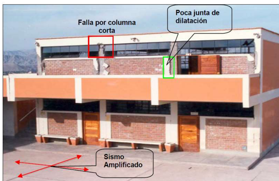
Figura 3.9 Falla por columna corta originado por gran desplazamiento lateral, C.E. Fermín del Castillo, ubicado en la zona más alta del distrito de Vista alegre, Quiun 1997.
