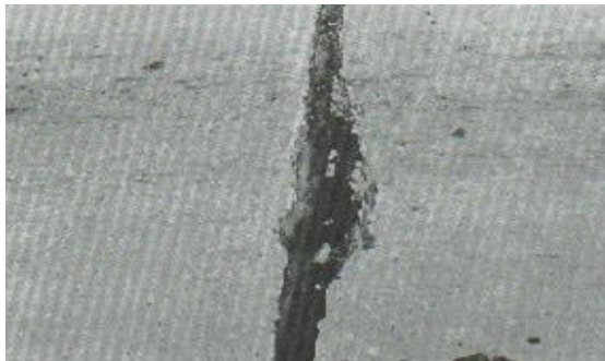
Figura 21. Daño del sello de junta de severidad media. Fuente: Traducción del libro de Shahin, M. Y. "Pavement Management for Aiports Roads anad Parkink Lots". 2005.
