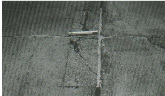
Figura 34. Parche pequeño de alta severidad. Fuente: Traducción del libro de Shahin, M. Y. "Pavement Management for Airports Roads and Parking Lots". 2005
