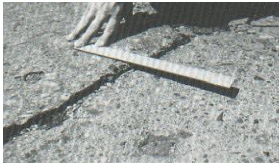
Figura 18. Escala de severidad media.
