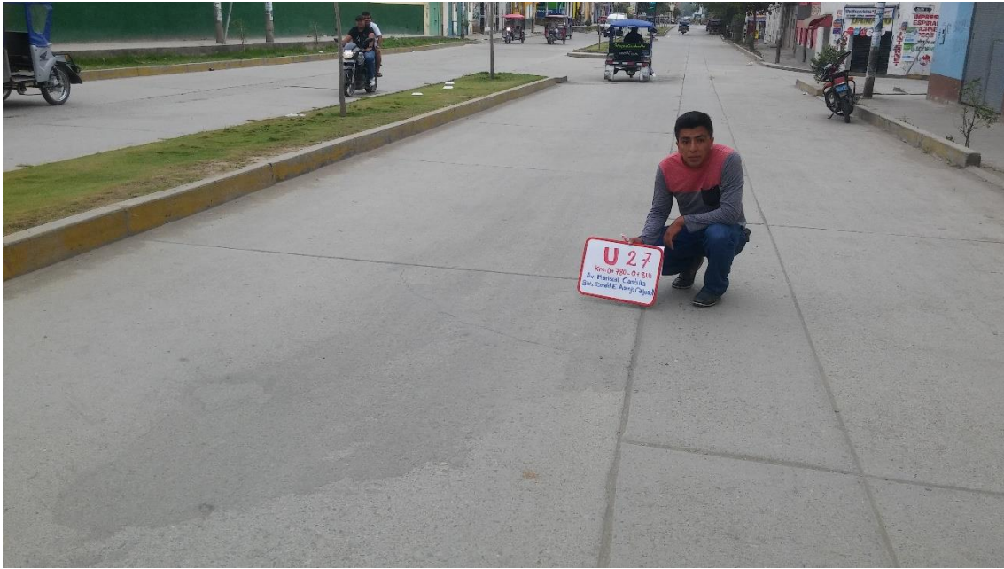
Figura 92. Muestreo de pavimento (U 27) km 0+780-0+810 en el tramo 02, en la av. Mariscal Castilla.
