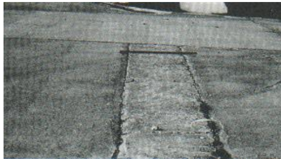
Figura 30. Parche grande y acometida de servicios públicos de severidad media. Fuente: Traducción del libro de Shahin, M. Y. "Pavement Management for Airports Roads and Parking Lots". 2005
