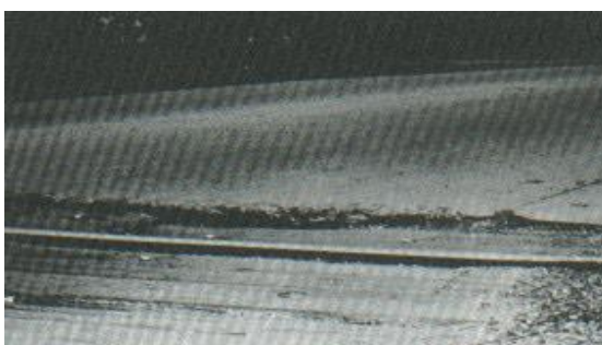
Figura 43. Cruce de vía férrea de alta severidad Fuente: Traducción del libro de Shahin, M. Y. "Pavement Management for Airports Roads and Parking Lots". 2005
