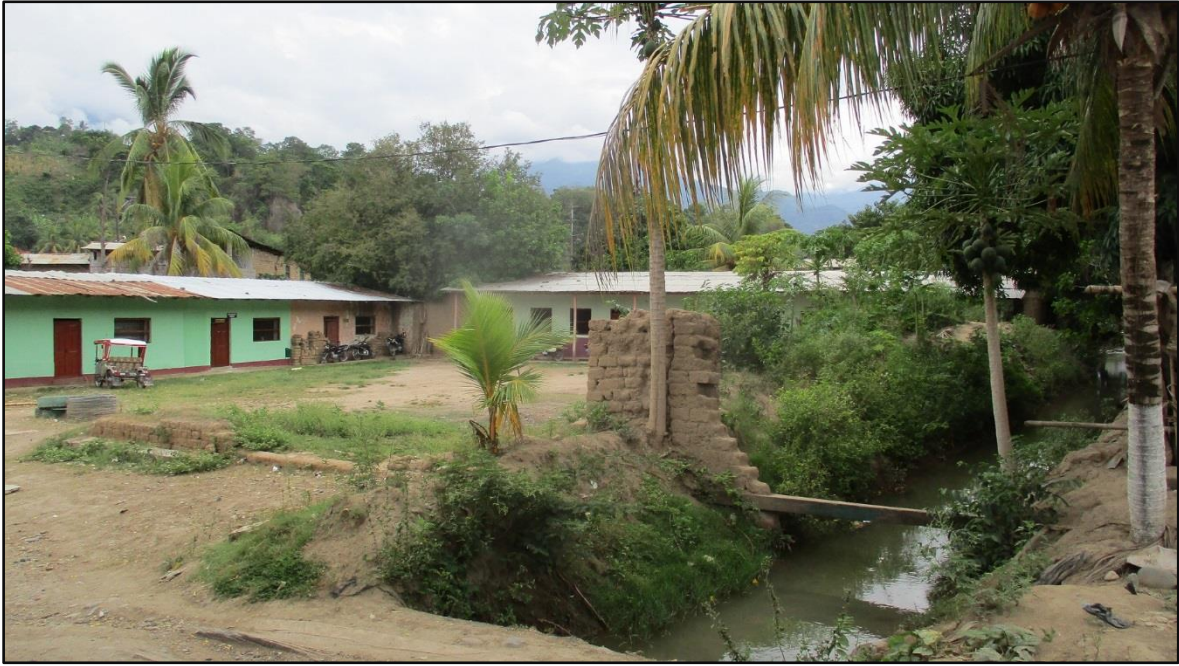
Figura 56: Aulas Institución Educativa en riesgo de inundación.
