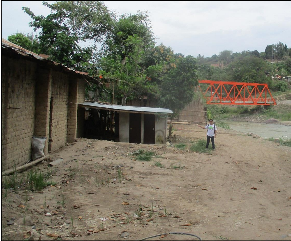
Figura 67: Viviendas construidas en la ribera del rio sobre rellenos con materiales de construcción.
