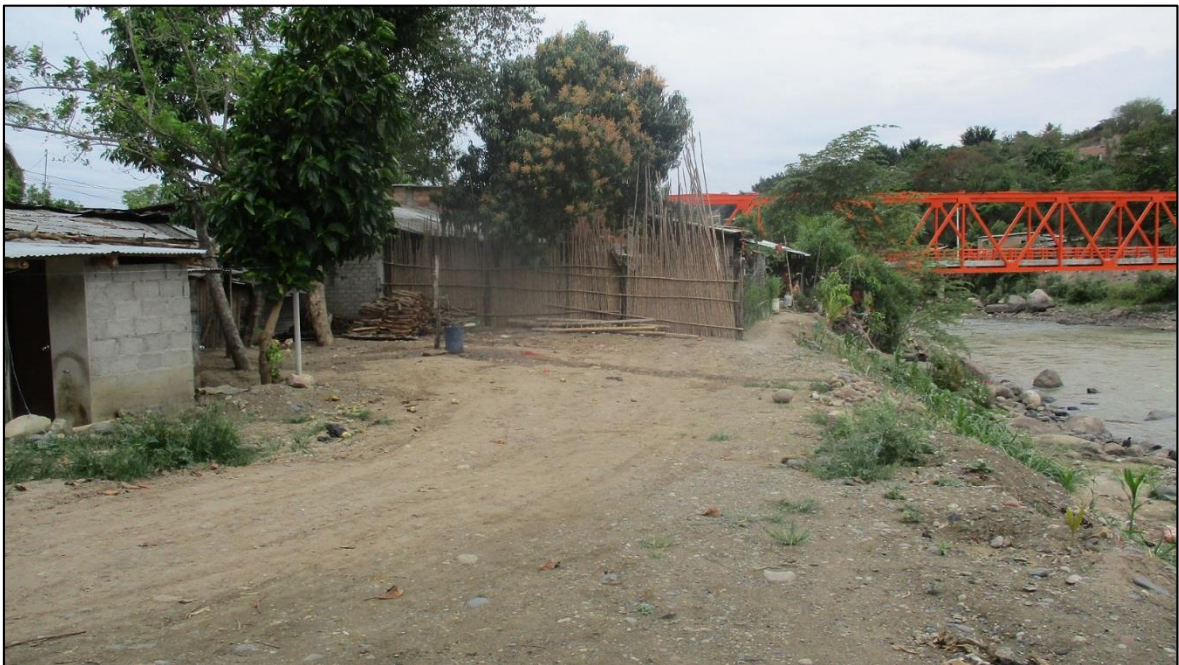
Figura 68: Viviendas construidas en la ribera del rio sobre rellenos con materiales de construcción.
