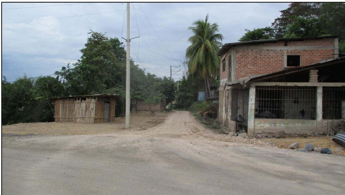
Figura 58: Viviendas en riesgo de inundación margen derecha aguas abajo.
