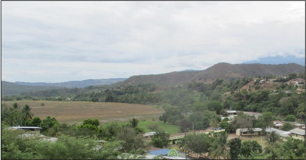
Figura 71: Áreas agrícolas afectadas por el desabastecimiento de agua por colapso del canal.
