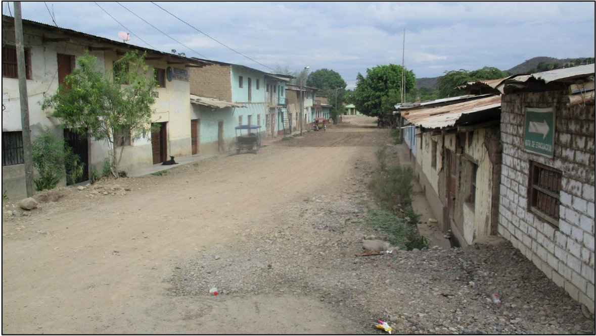
Figura 65: Viviendas y accesos margen Aguas abajo en riesgo de inundación, viviendas de material de adobe.
