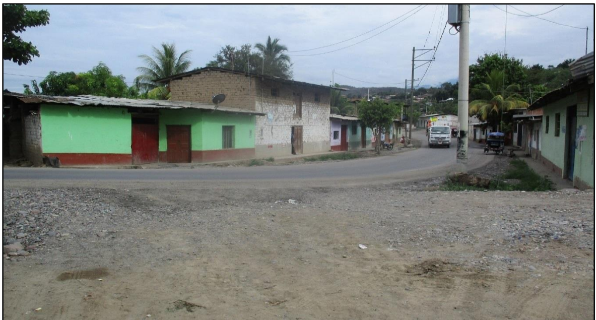
Figura 55: Viviendas y accesos en riesgo de inundación, margen izquierda.
