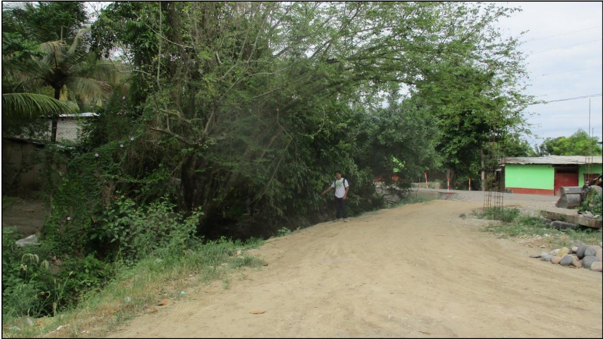
Figura 69: Canal de tierra que abastece con agua aproximadamente a 17 ha, afectados por la inundación.
