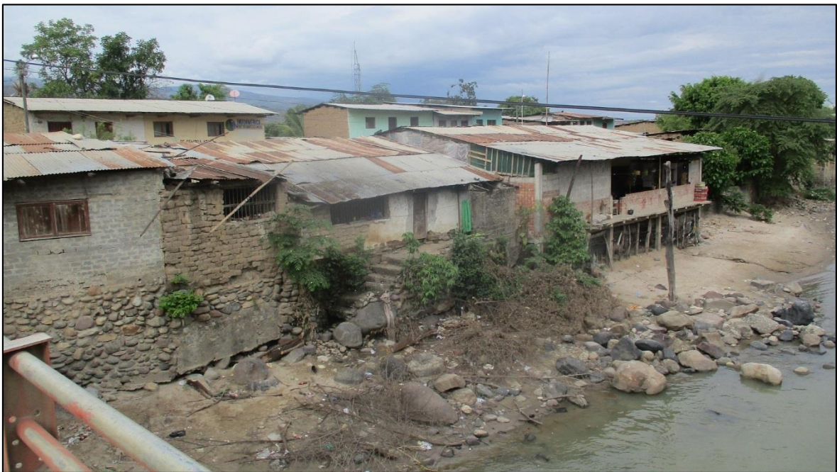
Figura 66: Viviendas construidas en la ribera del rio, aguas abajo en riesgo de inundación, propuesta de construcción de muros de concreto armado.
