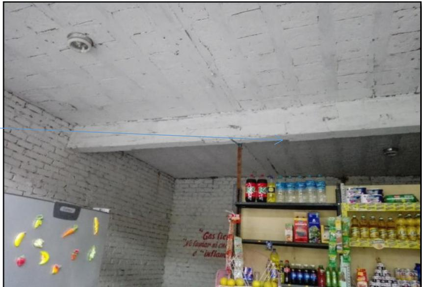
Vista de una pared de la vivienda. Las hileras no están muy alineadas. No hay buena ubicación de la tubería de luz.
