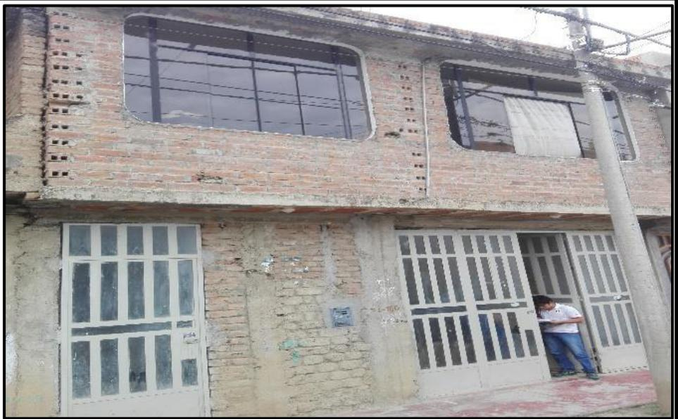
No existe junta sísmica
