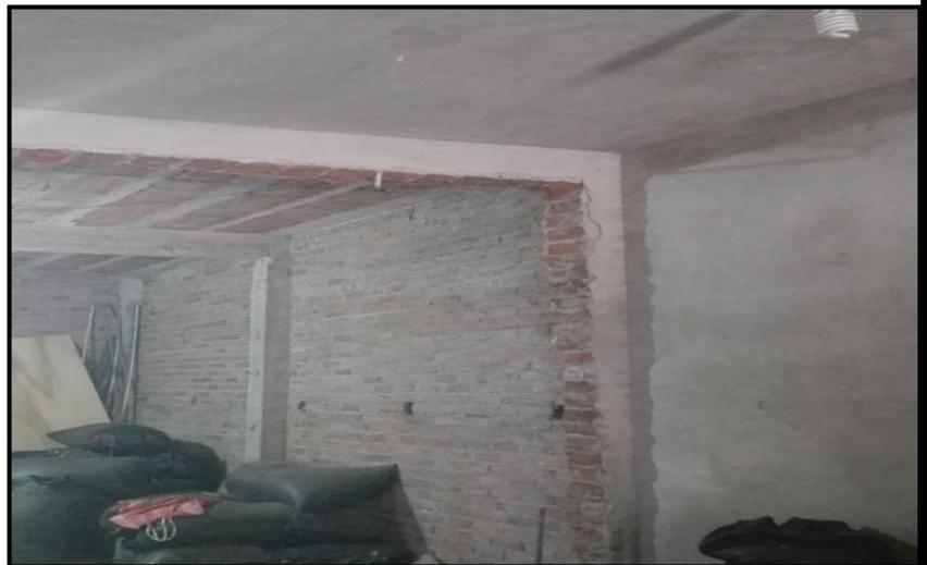
Colocación de una tubería de desagüe que baja del segundo piso por donde no es, separando al muro de la columna.
