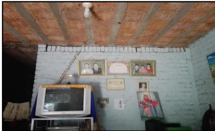
Juntas fría en viguetas y losa aligerada.
