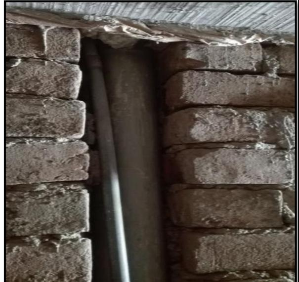
Tuberías de desagüe mal ubicadas.
