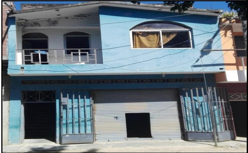
En la imagen se puede ver al muro que ha sido demolido para hacer un cajón y unir con la segunda construcción que se puede apreciar sus viguetas del techo aligerado y en la primera edificación el techo esta tarrajado.
