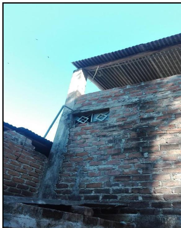
Humedad en muros y mala alineación de juntas
