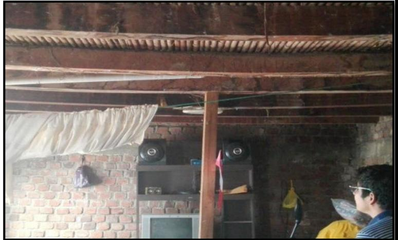
En la imagen se aprecia la edificación mas reciente que es del 2007, hay vigas con armaduras expuestas y elemento de concreto armado que presentan cangrejeras, tambien se ve que las viguetas de la losa aligerada no estan bien alineadas y que los ladrillos son deficientes.
