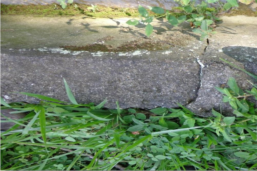
Figura 3. Agrietamiento en canales
