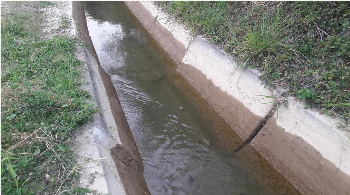
Figura 07: Desplazamiento del cuerpo de la estructura del canal El Progreso
