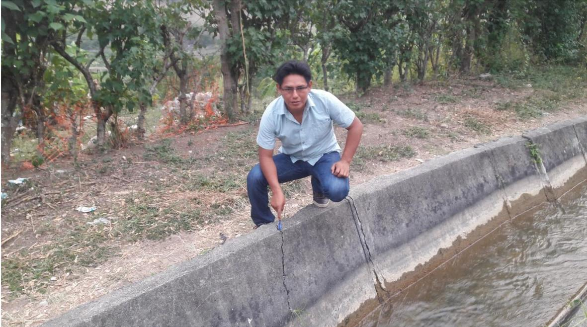
Figura 7. Agrietamiento en el cuerpo de la estructura
