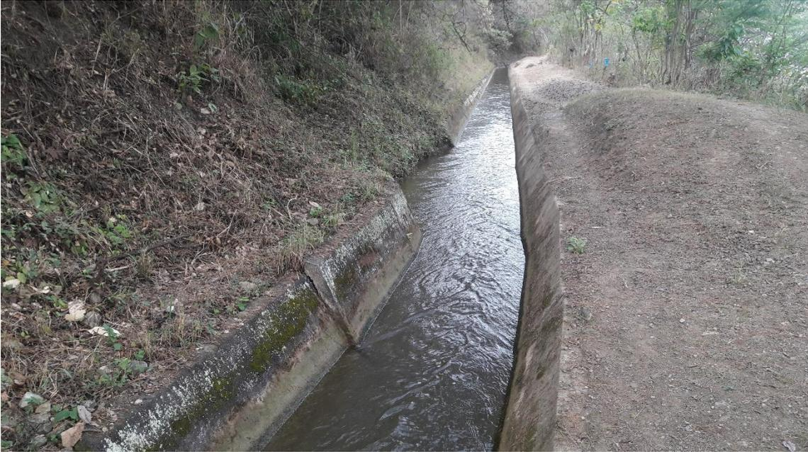
Figura 03: Vista longitudinal del canal El Progreso– Mayanal, se aprecia el deslizamiento del recubrimiento del Canal.
