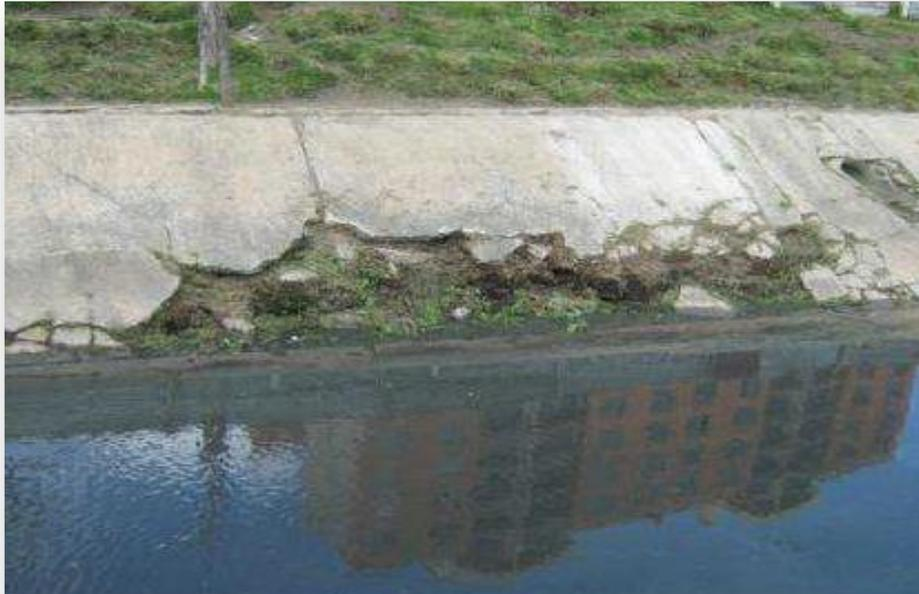
Figura 6. Erosión de la superficie en el cuerpo de la estructura
