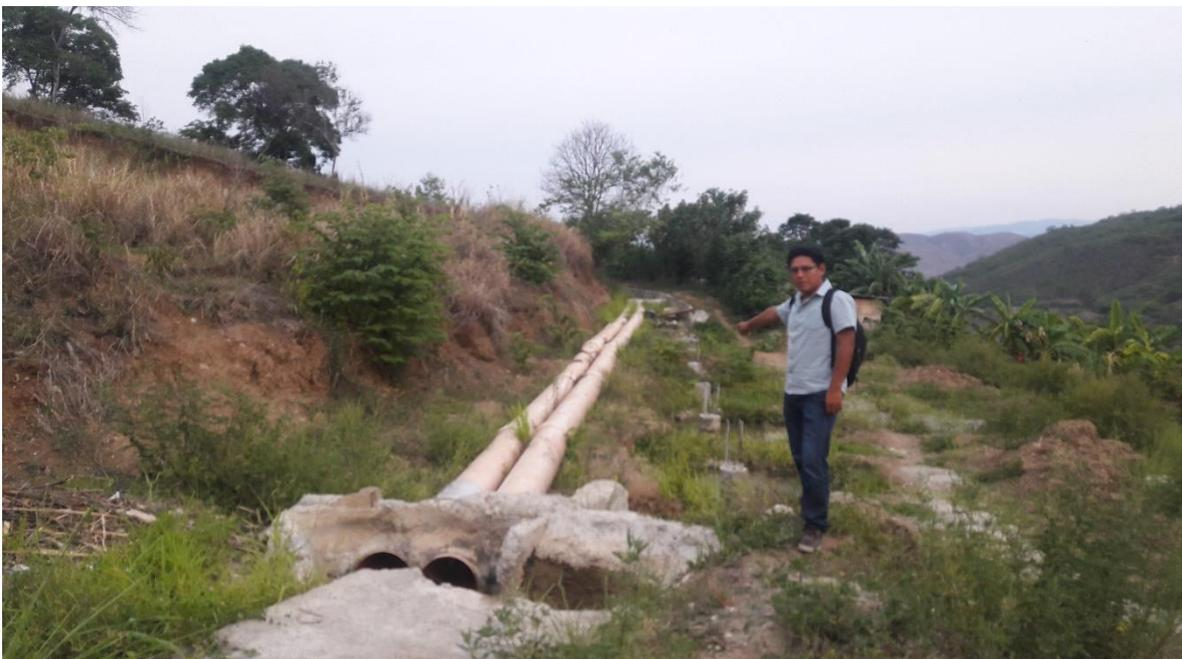
Figura 06: Continuidad del Canal el Progreso con 2 tubos de 12", a causa de los derrumbes
