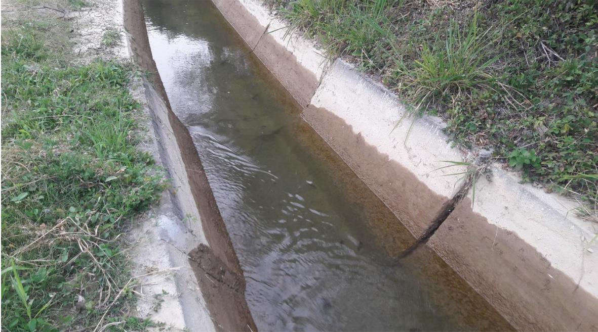
Figura 9. Erosión de juntas en el cuerpo de la estructura
