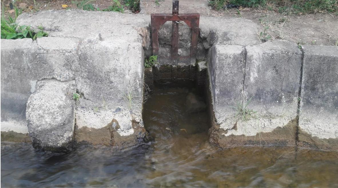
Figura 05: Obra de Arte, compuerta cerrada para realizar aforo.
