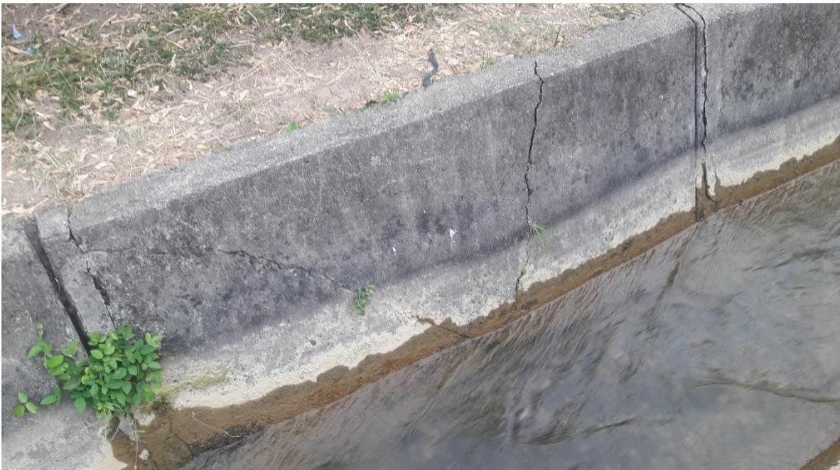
Figura 16. Condición de grieta en la progresiva Km 1+278 del canal.
