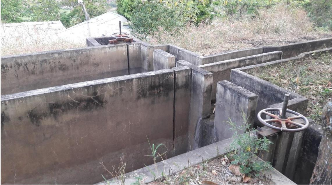
Figura 14: Estructuras de Sedimentador, que se utilizó como recipiente para calibrar los vertederos por el método volumétrico.
