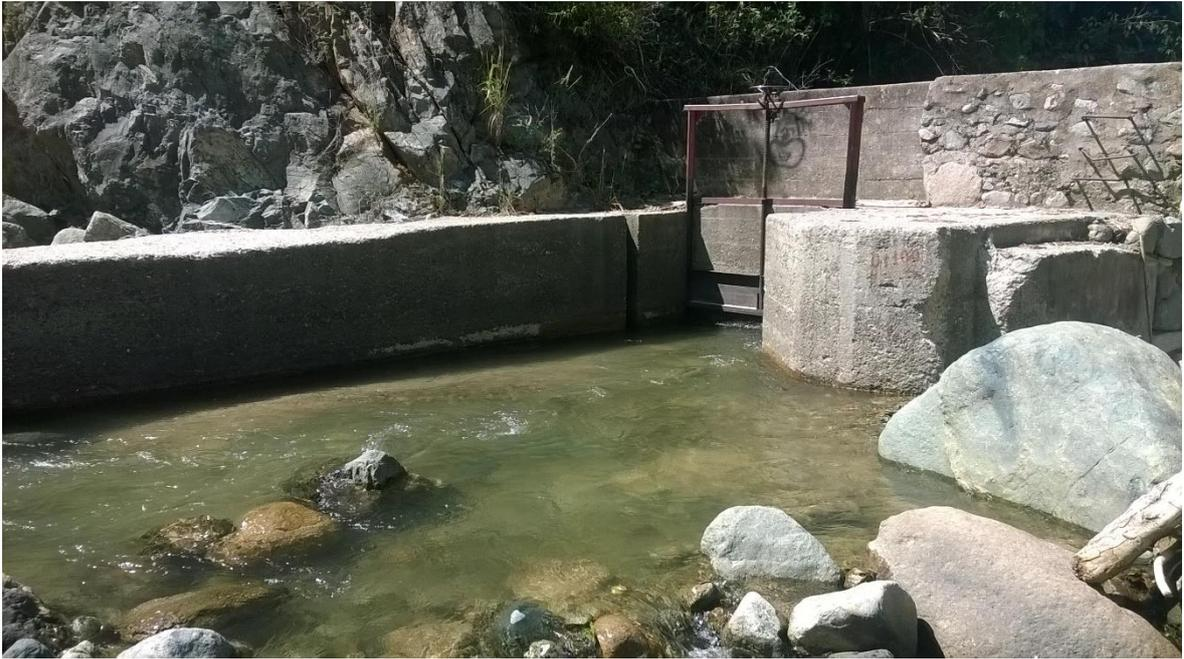
Figura 01: Bocatoma, inicio del canal El Progreso – Mayanal
