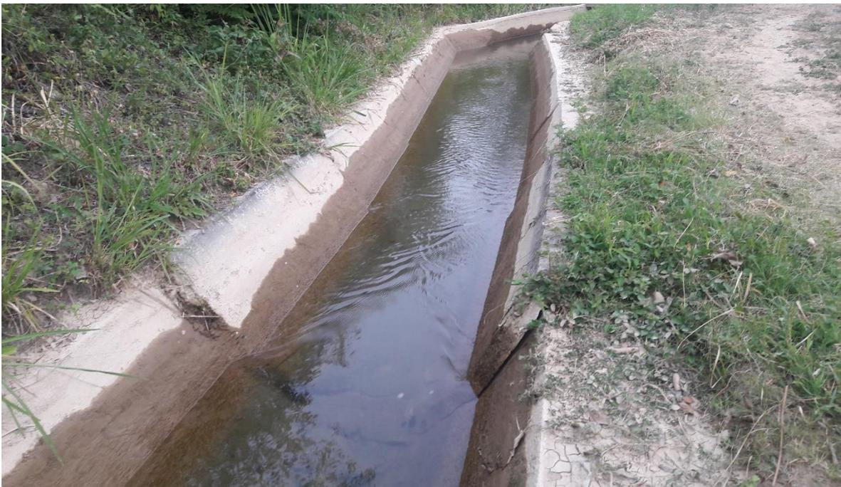
Figura 10. Desplazamiento de juntas en el cuerpo de la estructura
