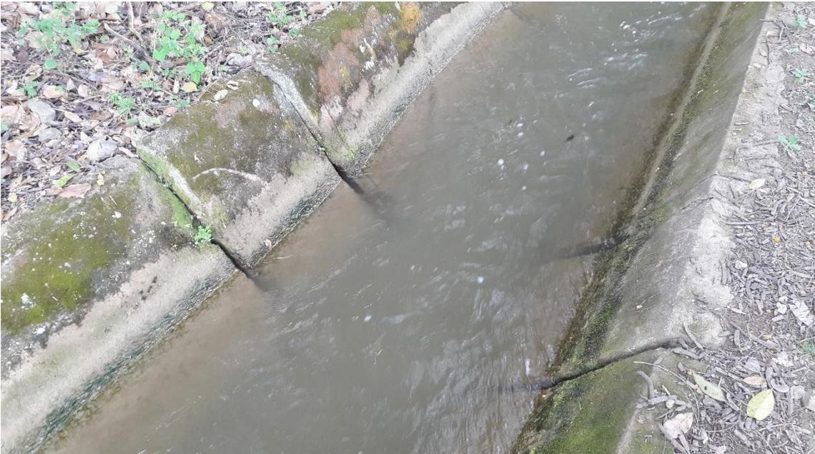
Figura 04: Se aprecia la ausencia del sello asfáltico en la junta de dilatación.
