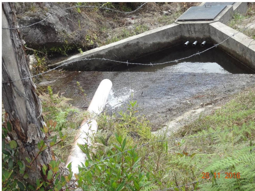
FOTO N° 18: vista de la captación.
