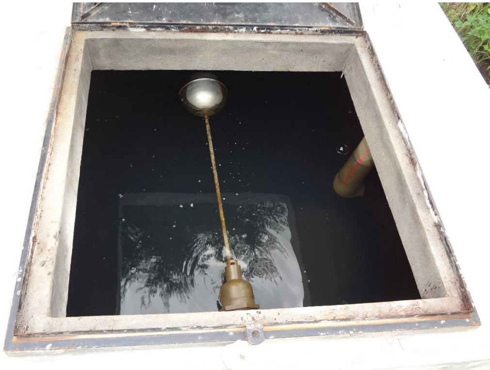
FOTO N° 15: vista de la captación
