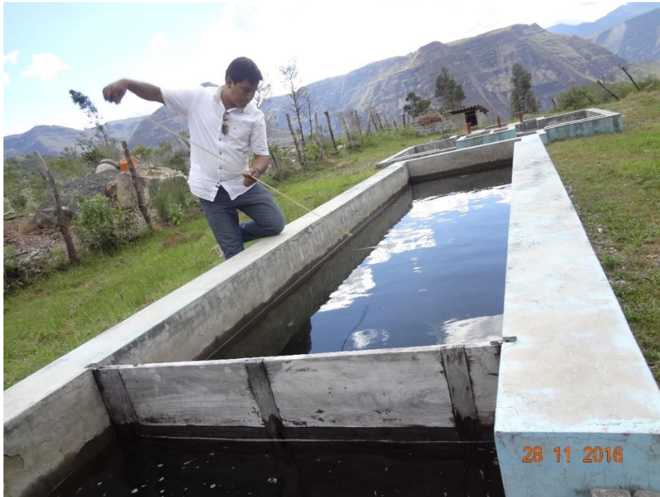
FOTO N° 04: realizando las medidas del sedimentador
