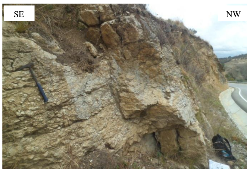
Figura 23. Estrato de calizas nodulares macizas de la Formación Mujarrún observados en tramo de la Carretera La Encañada-Celendín, en el sector de Quinuamayo Alto.
