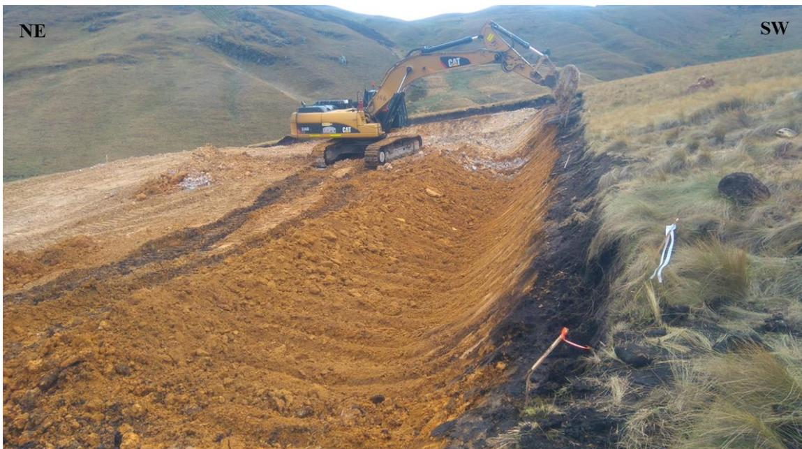
Foto 18. Retiro de la cubierta orgánica donde se observan suelos tipo morrénicos de consistencia areno-limoso y areno-arcilloso, determinados con exactitud mediante los ensayos.
