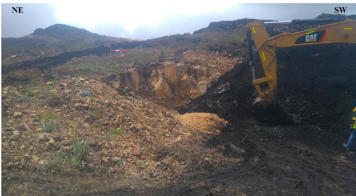
Foto 19. Suelo residual analizado mediante calicatas.
