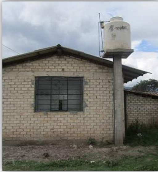
FOTO 5: Tanque para el suministro de agua.
