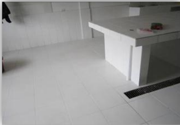
FOTO 4: Pisos y paredes de cerámicos, además de canaletas.
